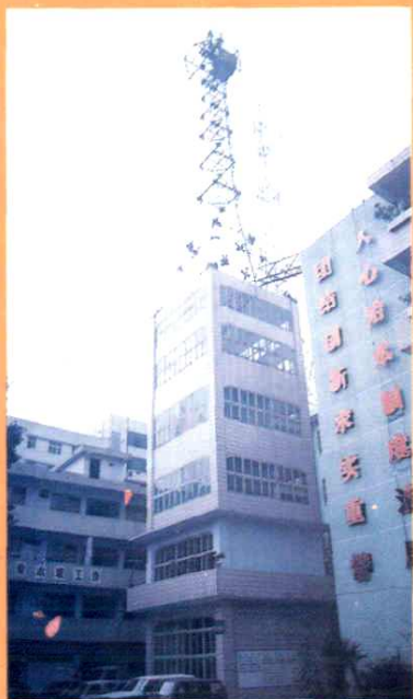
▼ 1984年遂寧市局一樞架微波塔塔樓建成。
