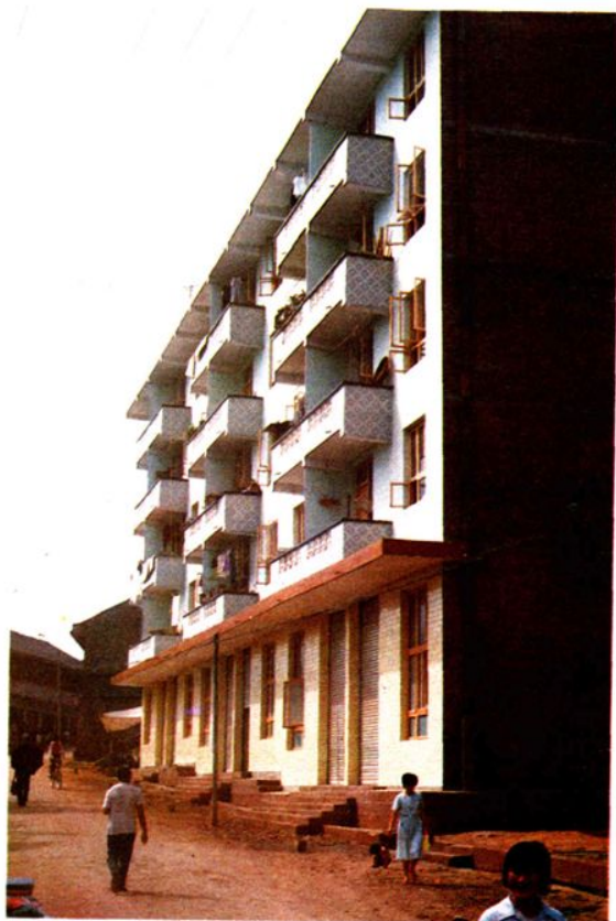
图为驯龙粮站综合大楼
