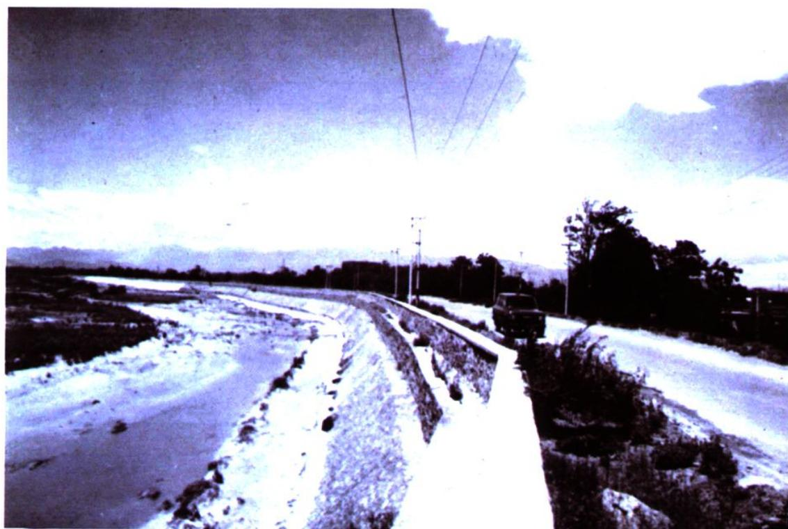
加固后的永定河卢沟桥上游左岸石堤
