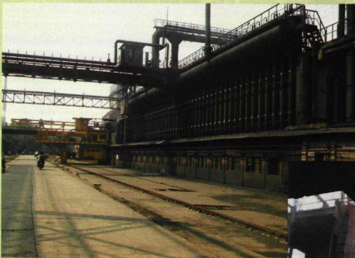
■ 新建的45孔JNX43-80型现代化焦炉雄姿
