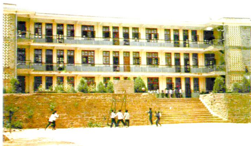
米甸初级中学教学楼
