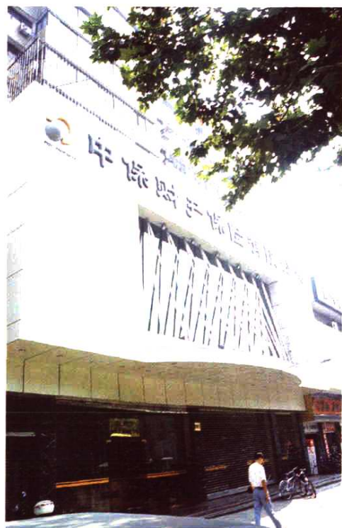
中保財產保險有限公司温州市分公司大樓
