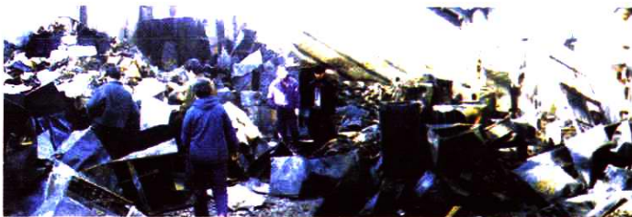
1993年，湖州五金交电化工公司发生火灾，人保湖州市分公司的理赔人员赴现场查勘
