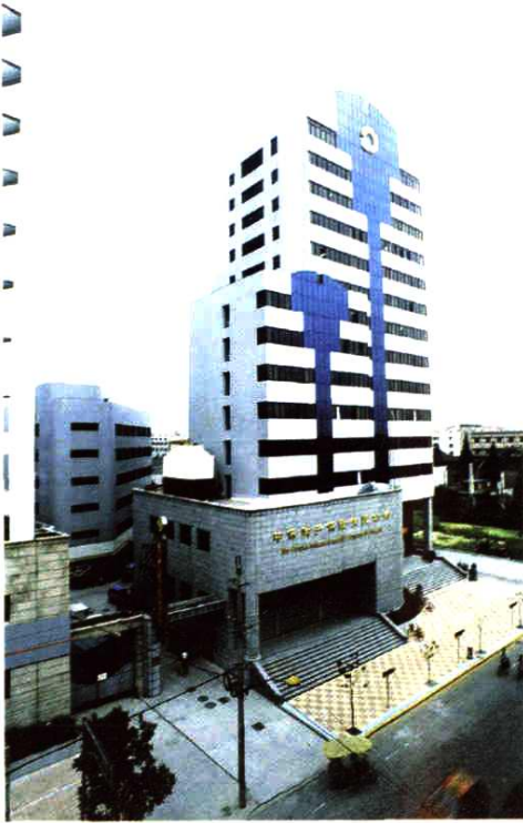
中保财产保险有限公司嘉兴市分公司大楼
