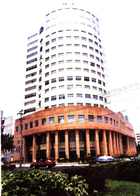
中国太平洋保险有限公司绍兴市分公司大楼
