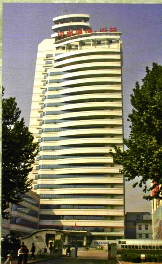
安阳电信综合楼基础支护工程(1997. 4)
