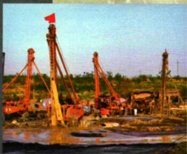
鹤壁二矿精选煤厂房基础处理工程(2004. 5)
