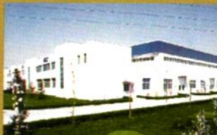
安阳电力开关厂工程监理(2001.8)
