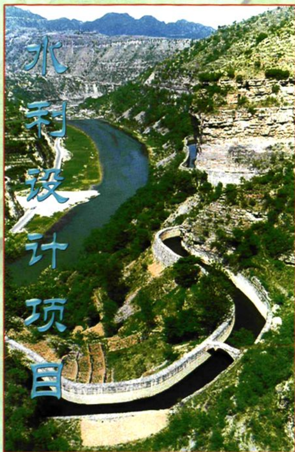
红旗渠技改工程 (1991~1997)
