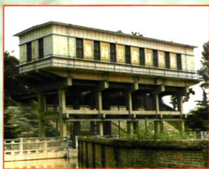
濮阳渠村引黄灌区进水闸(1983~1988)
