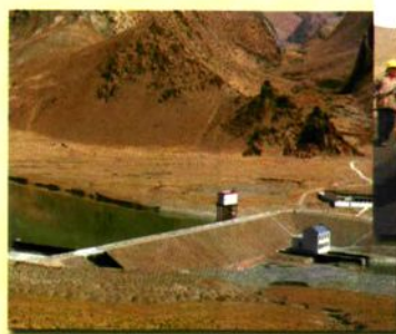
西藏日喀则地区萨嘎县加达水电 工程监理
