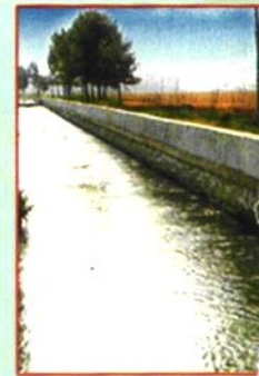
万金渠技改工程 (1991~)
