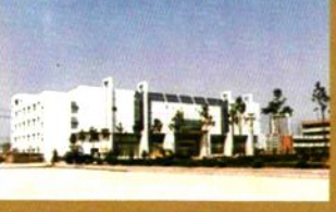
安阳师范学院餐厅工程监理(2003.9)
