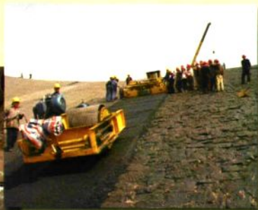
南谷洞水库除险 加固工程监理
