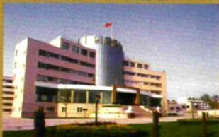
安阳海关大楼工程监理(2001.11-1999.12)
