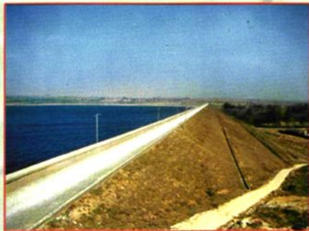
汤河水库除险加固工程(1975)
