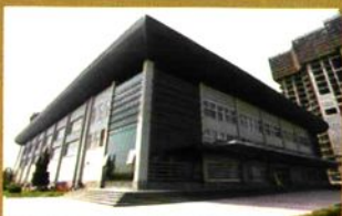
安钢游泳馆工程监理(2001.11)
