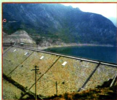
弓上水库除险加固工程 (1996~2003)
