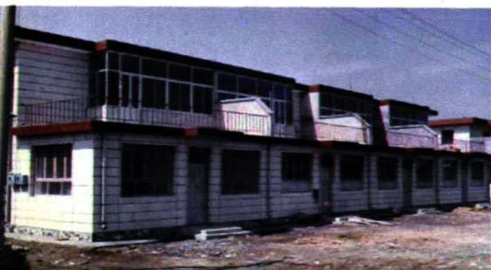
人民路 12 幢私人住宅楼
