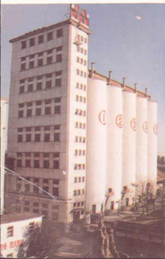
洛阳第二面粉厂钢板立筒仓
