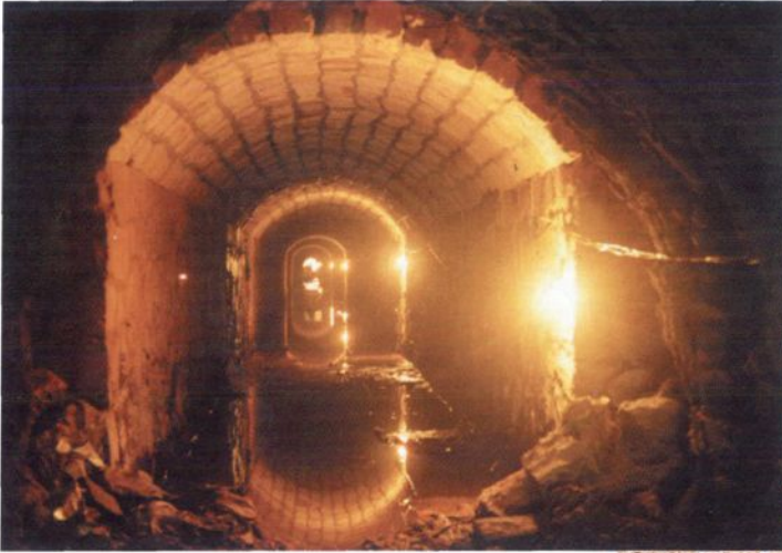
北干渠赤城隧洞续建施工
