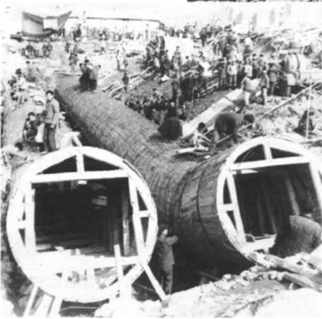
北干渠溪头陈倒虹吸施工
