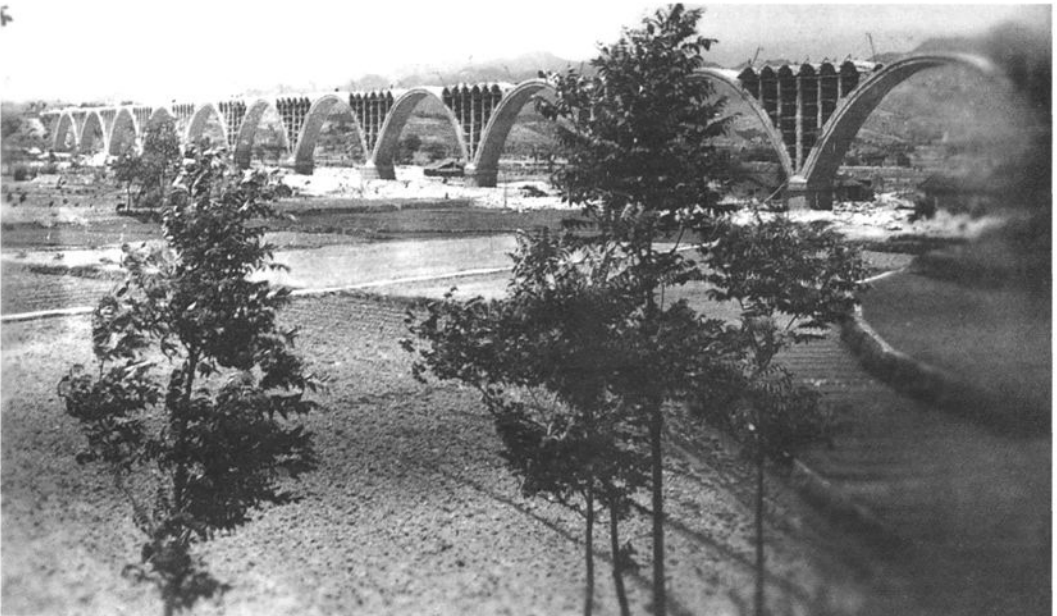
北干渠红旗渡槽施工全景
