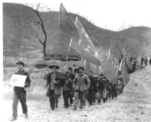
民工连进驻工地
