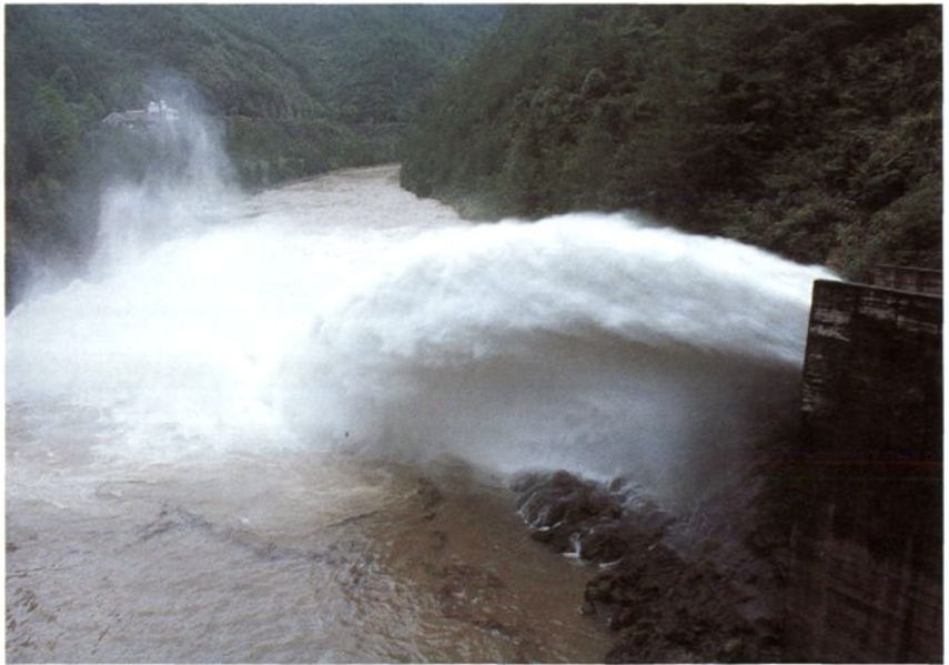
大坝泄洪洞泄洪
