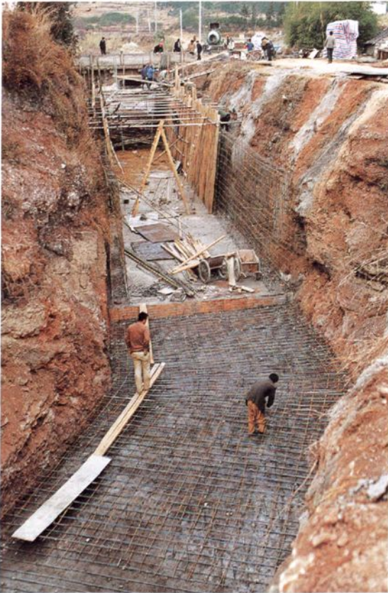
北干渠道者庵箱涵续建施工
