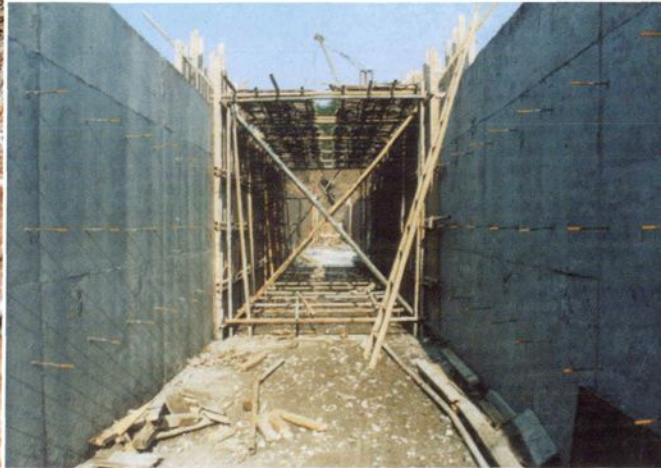
北干渠丰濂渡槽续建施工
