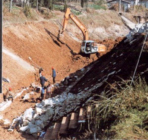
北干渠溪头陈明渠续建施工
