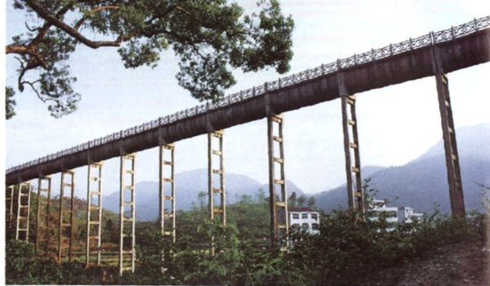
北干渠桃源渡槽
