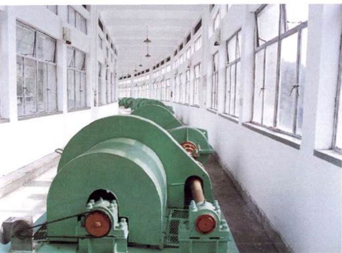
大坝溢洪道启闭机房
