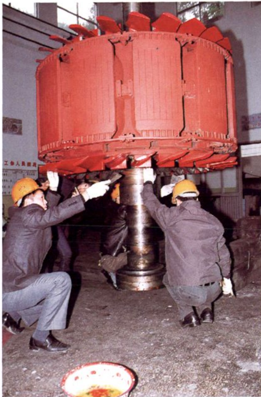
发电机吊芯检修
