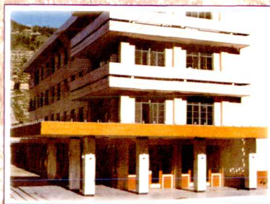
县医院住院部大楼
