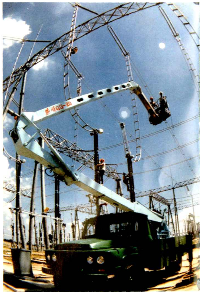
徐州送变电工程公司在 500 千伏改进工程中施工
