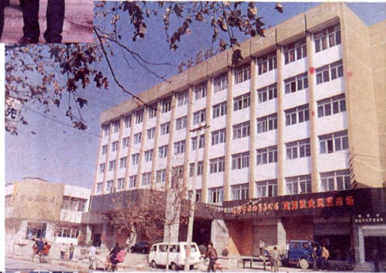
地处闹市区的鹰潭粮食局金谷园饭店
