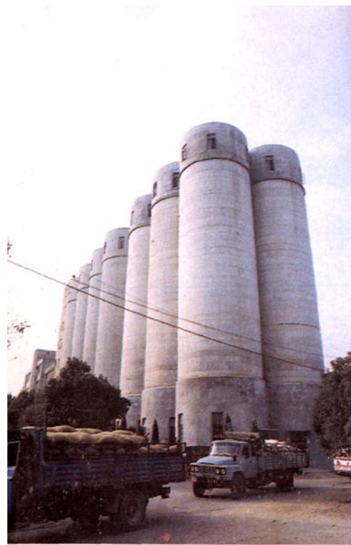
鹰潭市面粉厂立筒库
