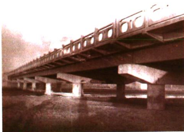
右图:大莫力克桥(钢板联 合梁结构)
