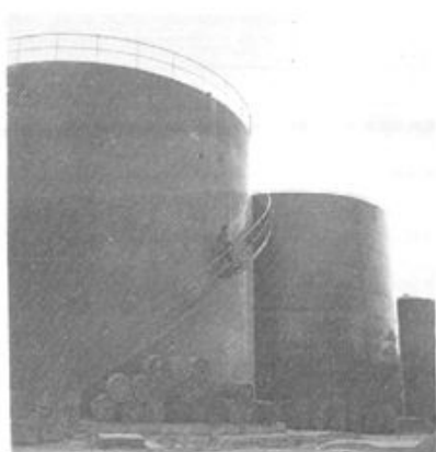
松江油脂化工厂一万吨钢板储油筒 (1981年建造)
