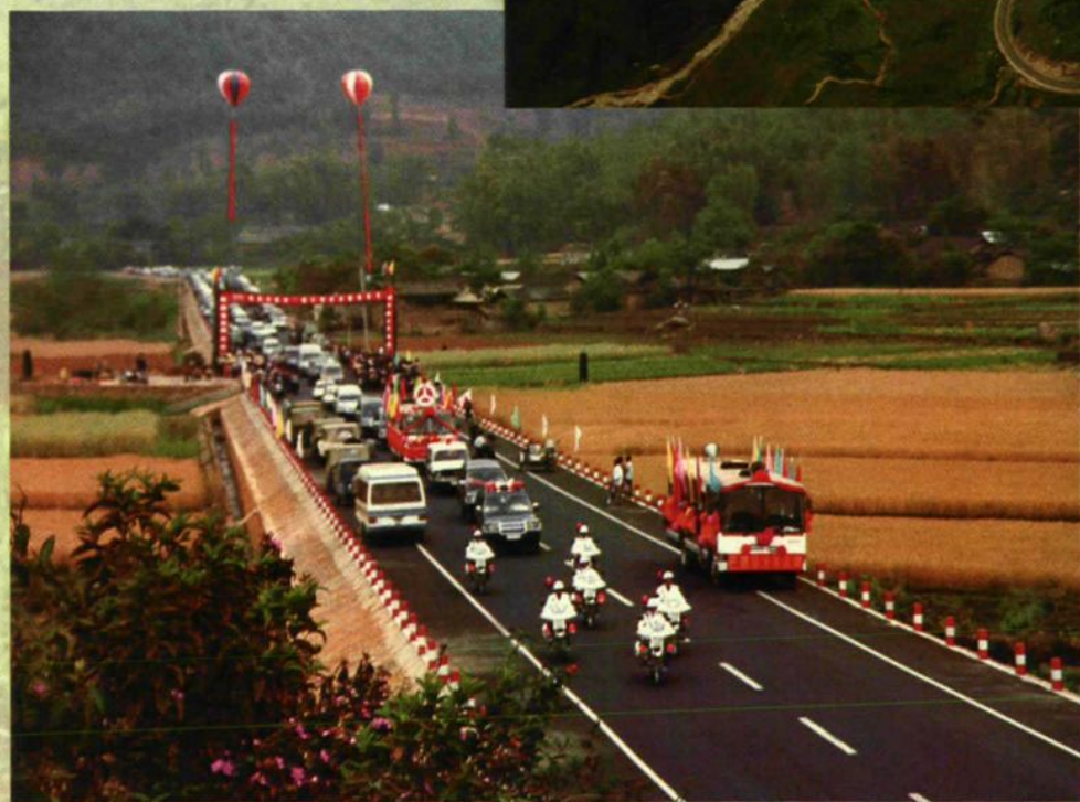
320国道芒瑞段竣工通车 (陈吉星 摄)
