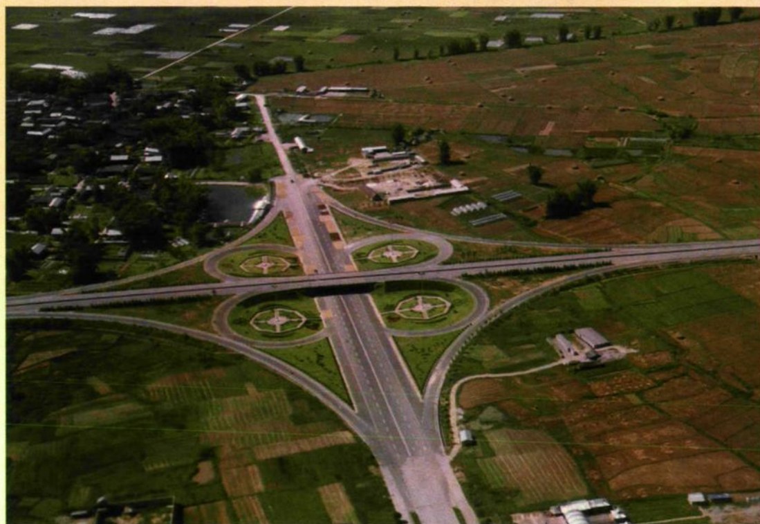
三二〇国道芒市过境段立交桥 (陈吉星 摄)
