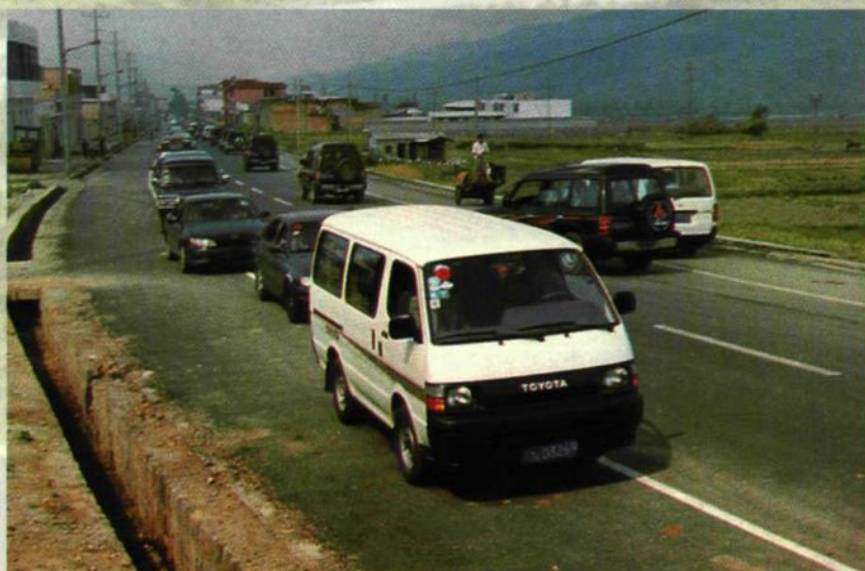
腾瑞线梁河县城过境段改建工程竣工通车
