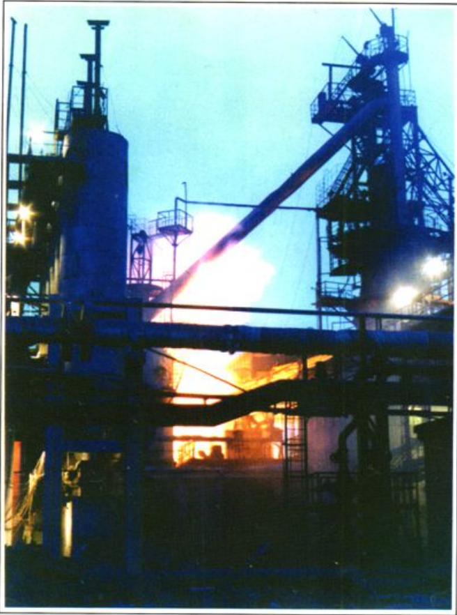
● 江油钢铁厂炼铁高炉
