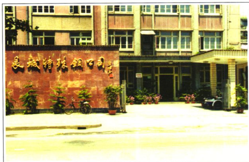
● 长城特殊钢公司办公大楼
