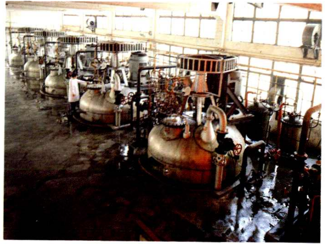
上海第三制药厂“中国黄” ——盐酸四环素生产线
