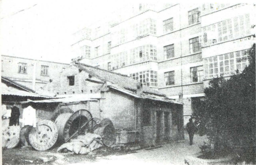
新建邮电职工宿舍楼一幢〈面积1080M 2 〉1983年建成 (高海权 摄)
