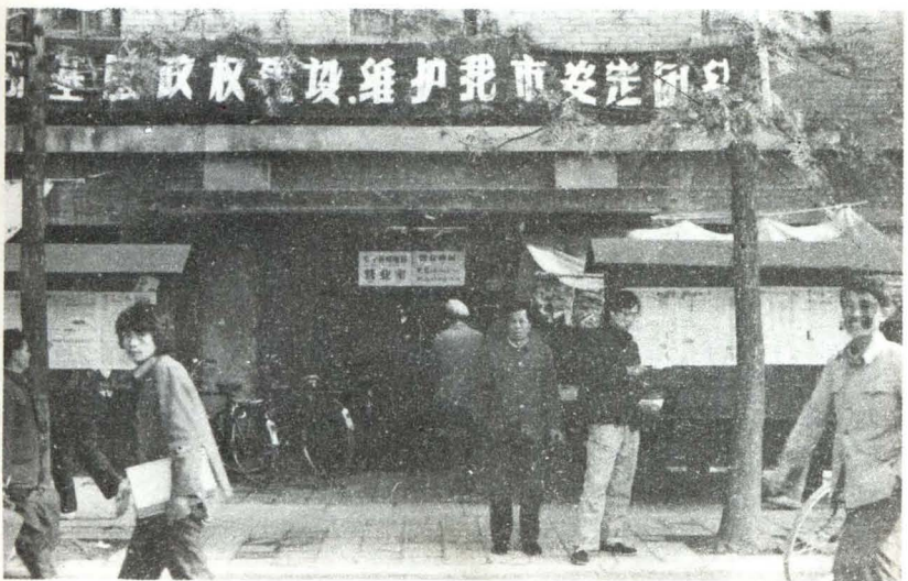
县局邮电营业楼，1968年建盖。（高海权 摄）
