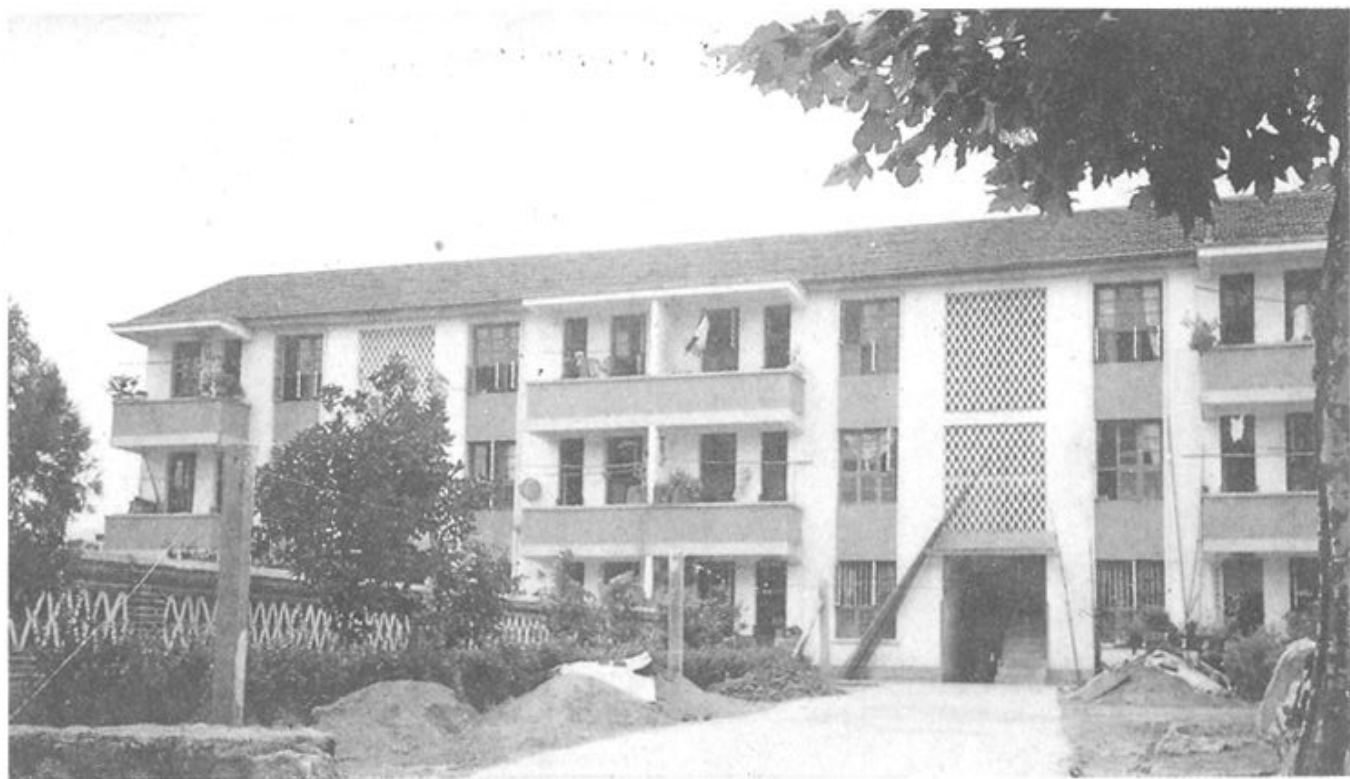
5. 县检察院第二栋干警住房
