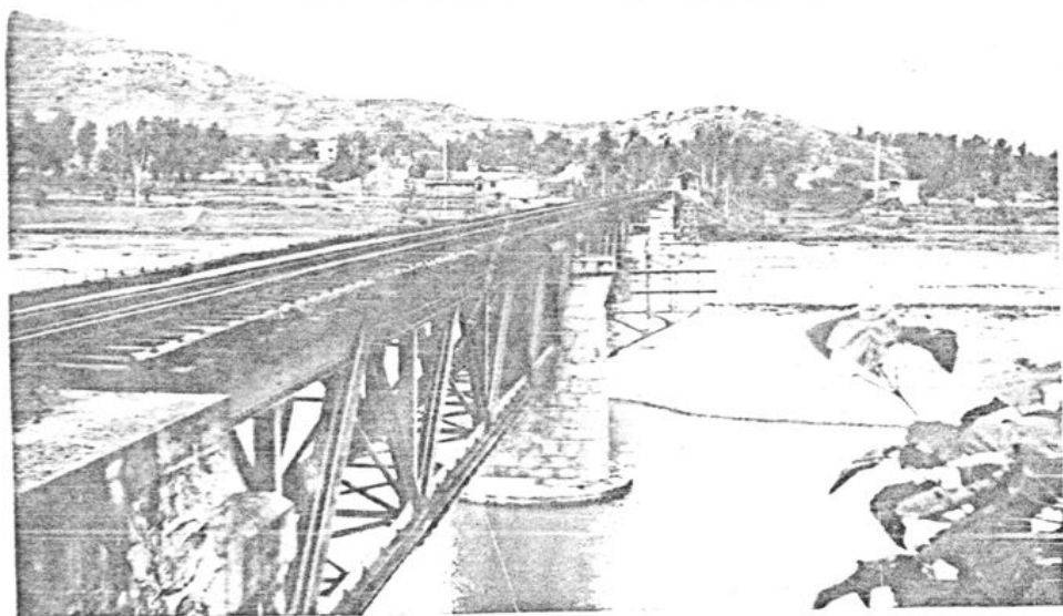
明泌铁路毛集大桥
