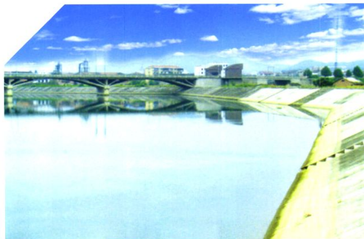
2005年5月鸣凤城 区防洪工程完工
