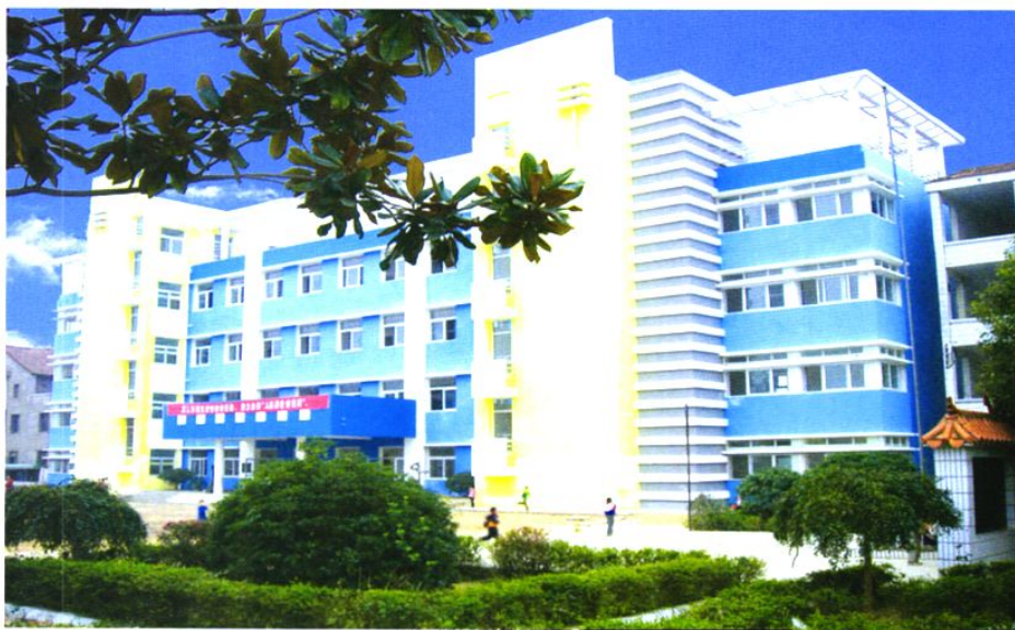
远安县鸣凤镇南门小学教学楼（2005年摄）
