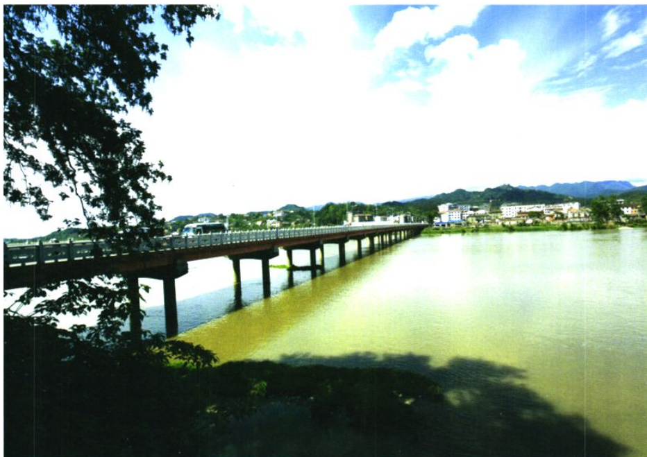
翻修改造后的鸣风沮河一桥（2008年摄）
