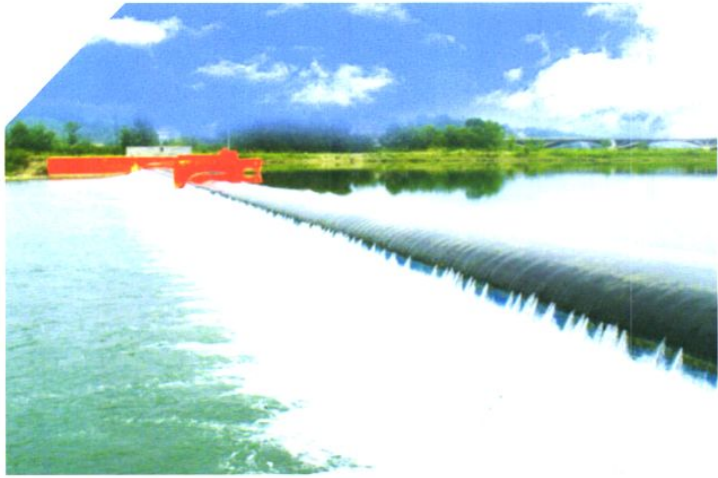
2003年4月沮河 (将军寨)橡胶坝工 程竣工
