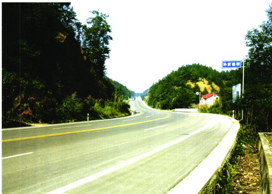
2000年12月开工改扩建的远当一级公路孙家寨路段
