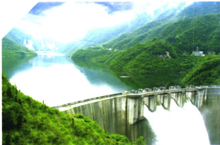
2005年7月玄庙 观水利水电枢纽工程 发电运行
