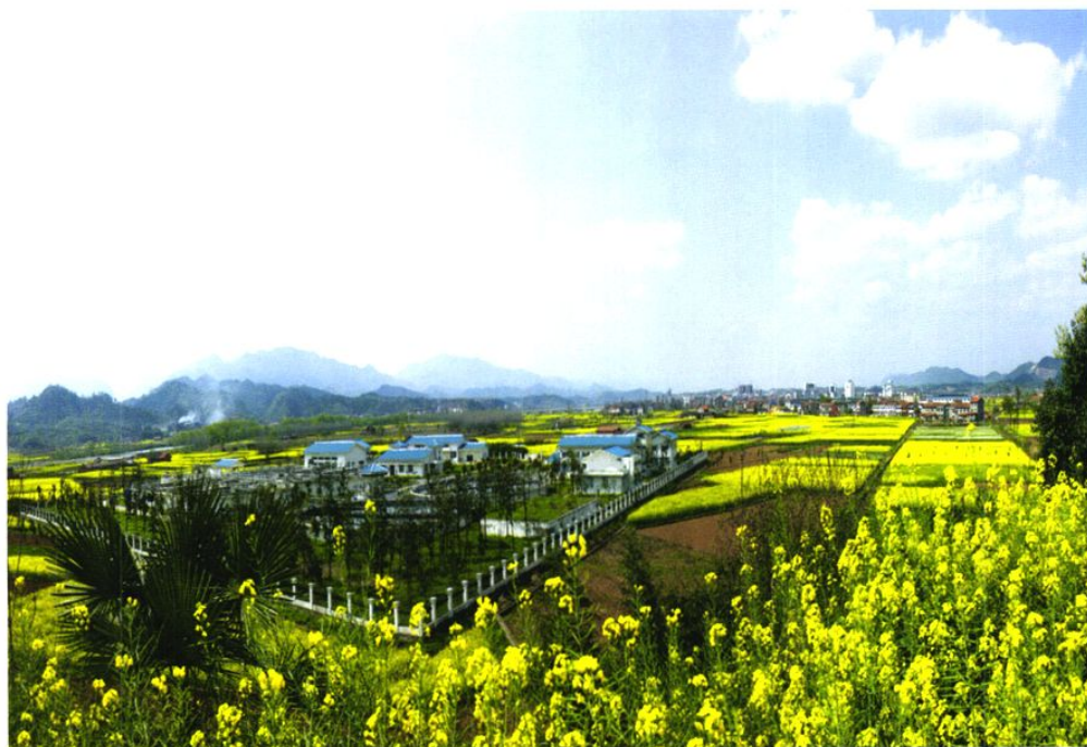
2004年6月动工兴建的远安县污水处理厂
