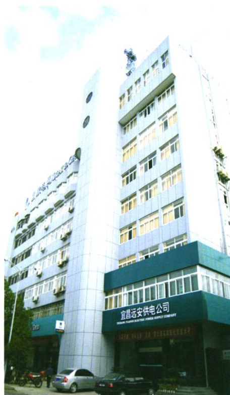
1992年12月竣工的远安供电大楼
