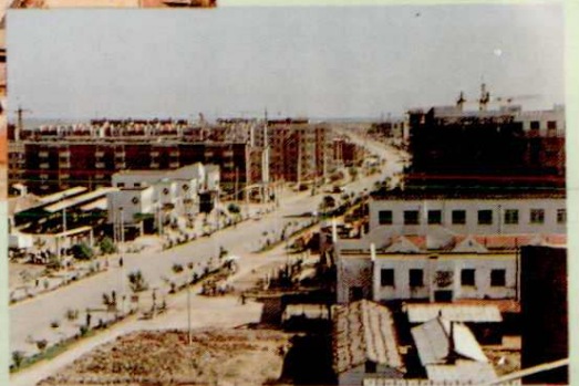
2. 市府机关南四村住宅小区 孙振波 摄
