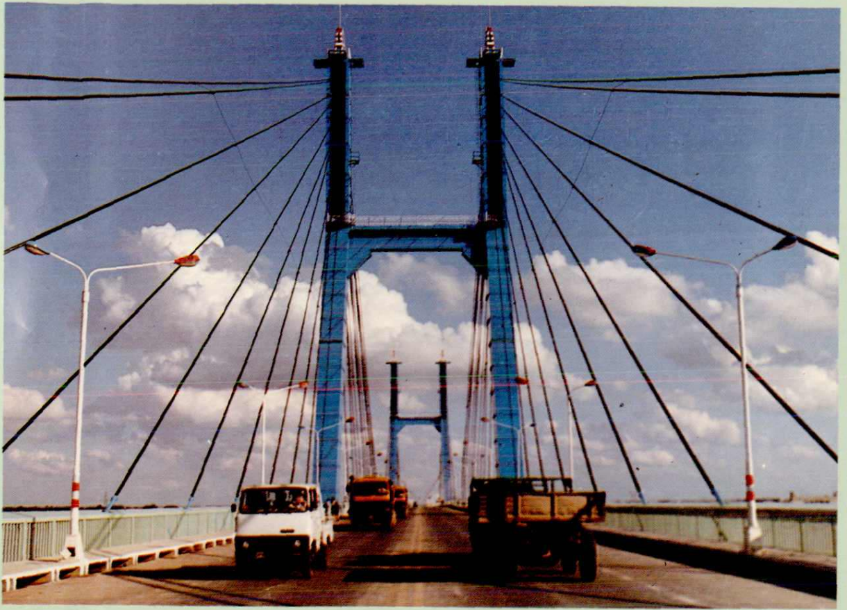
1. 矗立在垦利县城北端的胜利黄河大桥 王俊生 摄
