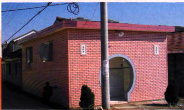
新建公共厕所之一，全村共建设公用厕所9座
