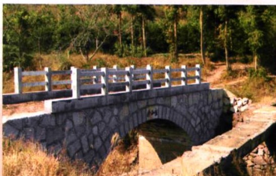
新建过北干渠三座桥梁之一的龙山桥， 右边的是建桥前山洪渡漕代人行桥。
