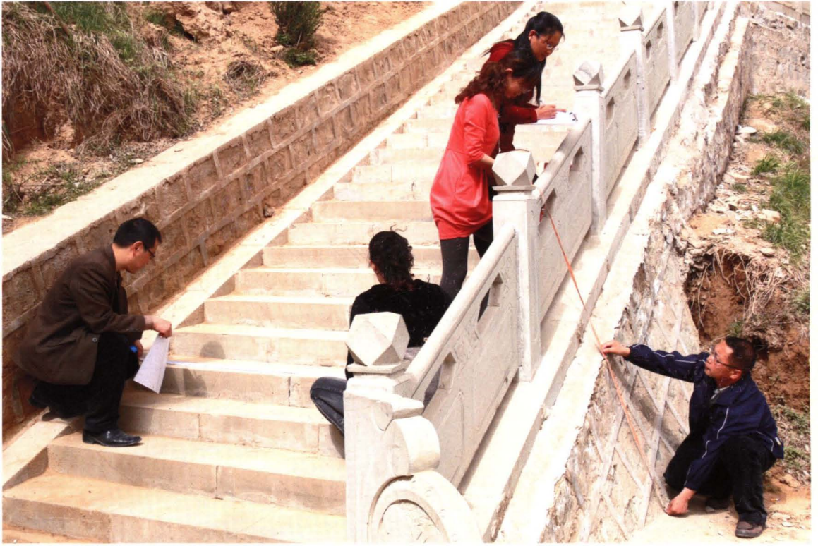
审计人员对城区四山治理工程实地测量。
