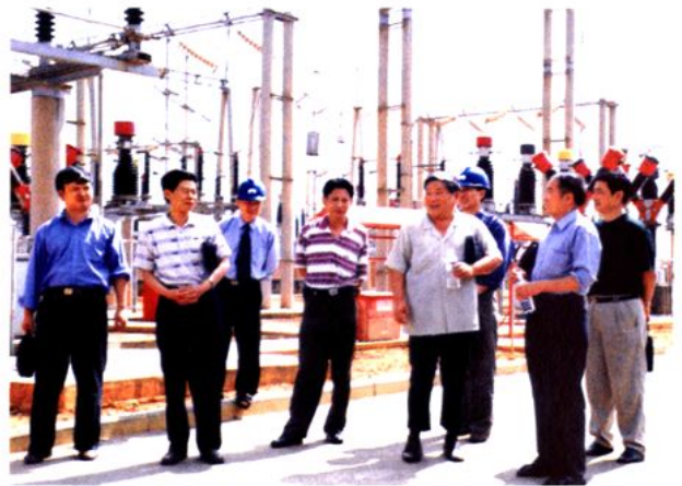
市劳动安全监察部门检查平地变电站的安全运行情况
