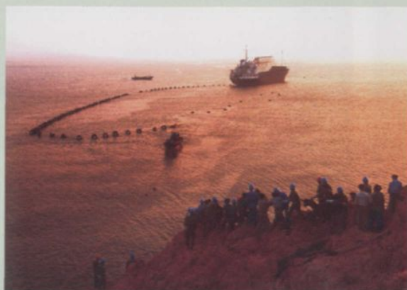
▶ 2004年，泗礁岛—大洋山岛岛际电力联网工程海缆敷设
