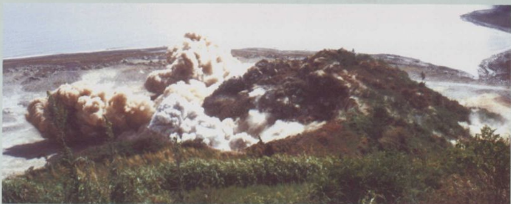
▲ 1995年1月18日，舟山发电厂建设工程开山平基第一爆
