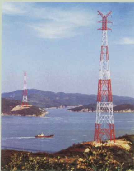
▲ 110千伏舟山至岱山交流双回路电力联网工程跨度3699米的灌门大跨越
