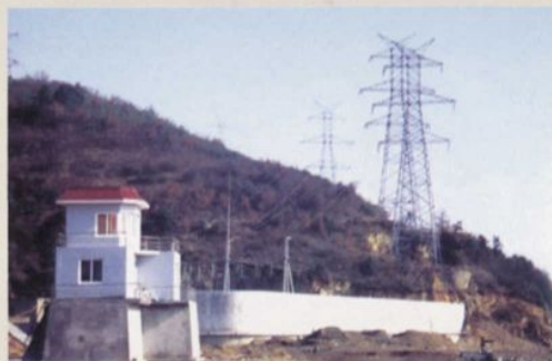
▶ 110千伏大陆至舟山交流双回路电力联网工程金塘岛黄蟒山终端站
