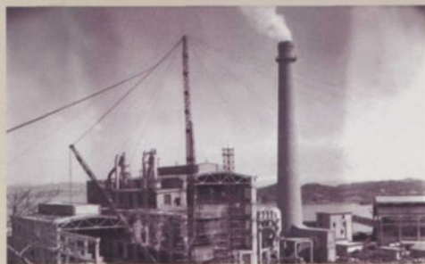
▲ 1984年4月，定海电厂二期工程建设
