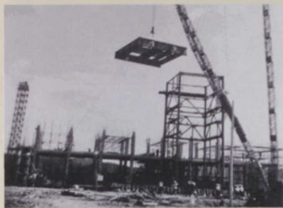
▲ 1978年10月，定海电厂一期工程建设
