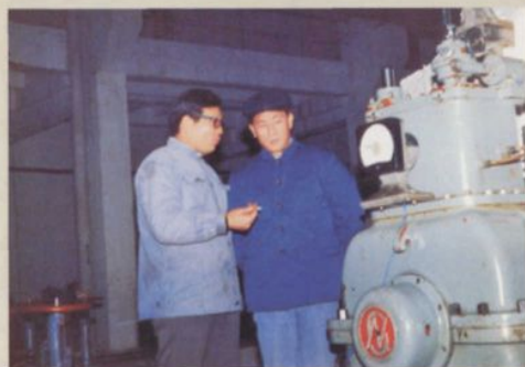
▲ 1985年11月，定海电厂3号机组整套启动调试
