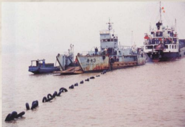
◀ 110千伏大陆至舟山交流双回路电力联网工程册子水域海缆敷设
