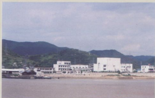
◀ -100千伏大陆至舟山直流输电工程舟山逆变站
