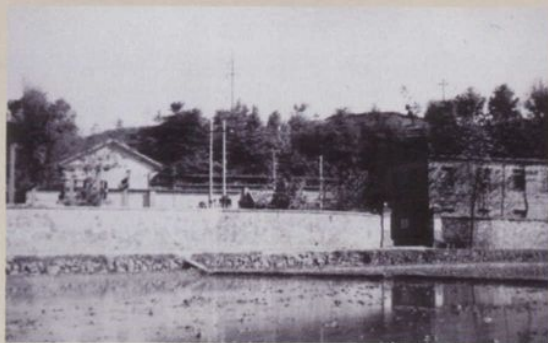
▲ 建于1955年的地方国营定海电厂蟠洋山发电车间
