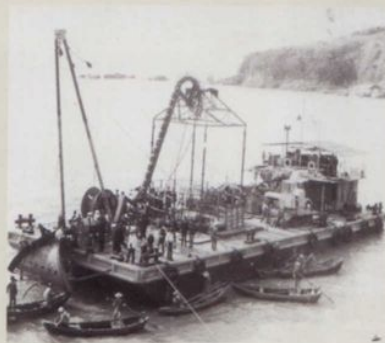
▲ 1983年5月，舟山第一条10千伏海缆—沈家门至普陀山海缆敷设成功
