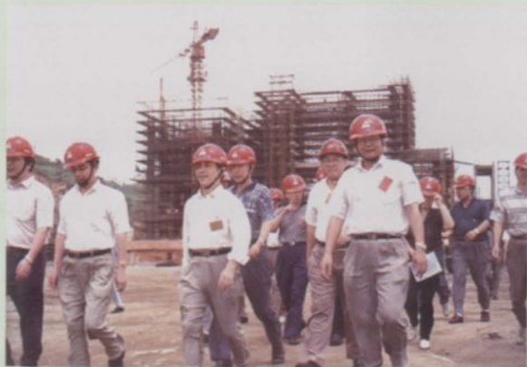
◀ 1996年8月1日，浙江省副省长张启楣视察舟山发电厂建设工地
