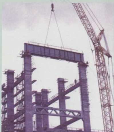
▲ 1996年9月22日，舟山发电厂1号机组第一根锅炉大板梁吊装就位
