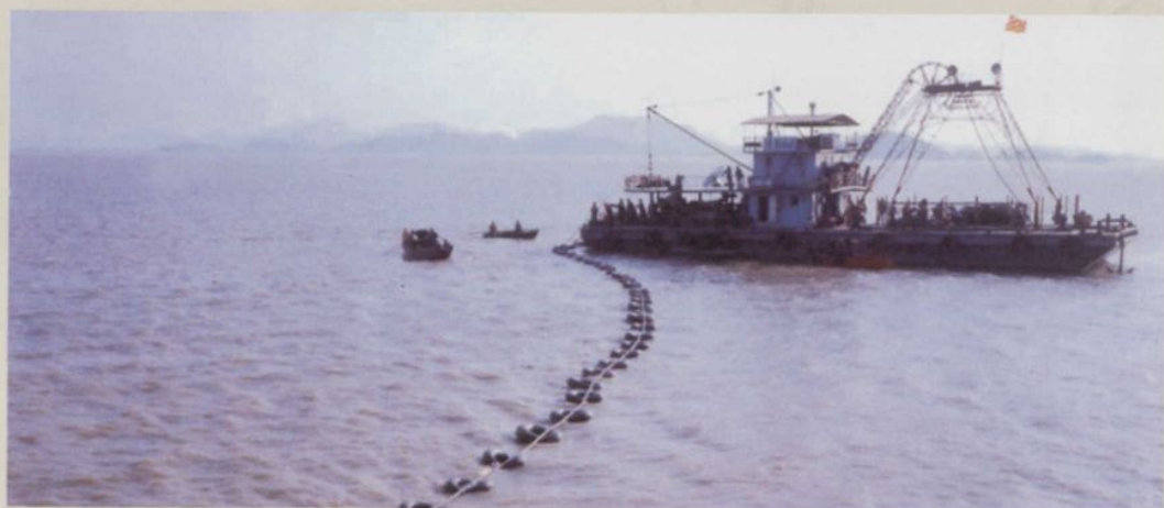
▲ 1986年5月，敷设-100千伏大陆至舟山直流输电海缆
