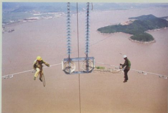
◀ 2000年10月，110千伏舟山至岱山交流双回路电力联网工程动工兴建
