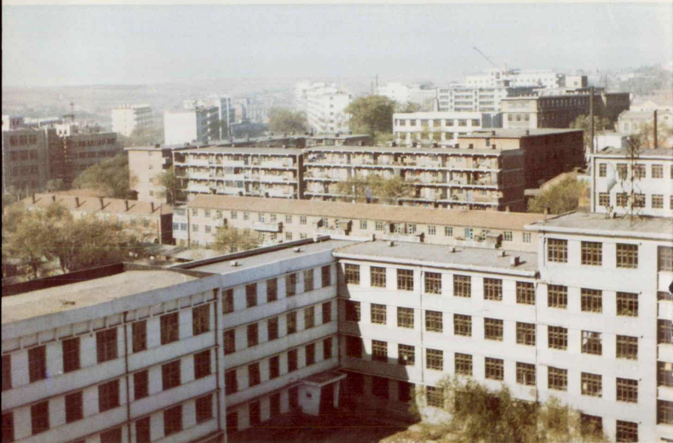
80年代鸡西矿区工会办公楼及矿务局南山地区职工住宅群
