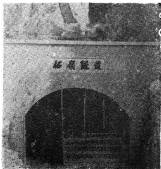
正在掘进中的柘岭隧道入口处
