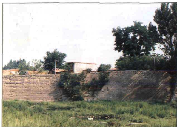
清咸丰十年建围墙遗址（大南门东侧）
