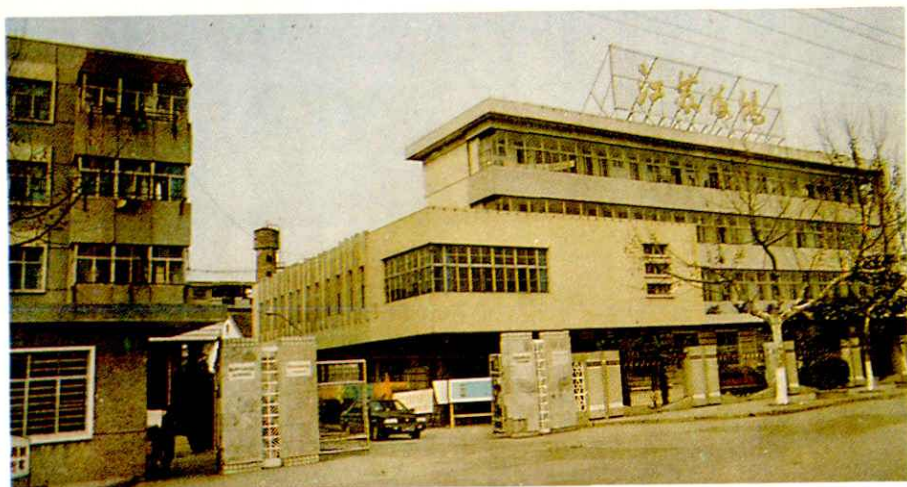
射阳县合德轧花厂办公楼
