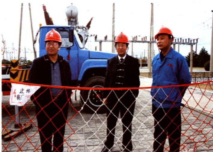
2007年11月5日，公司副经理马杰（中）深入220千伏铺上变电站主变大修现场，指挥检修。
