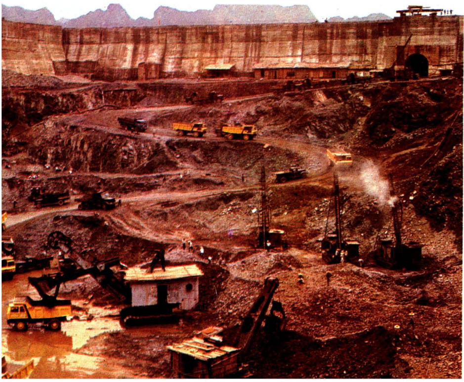
大化水电站一期厂坝基础开挖施工
