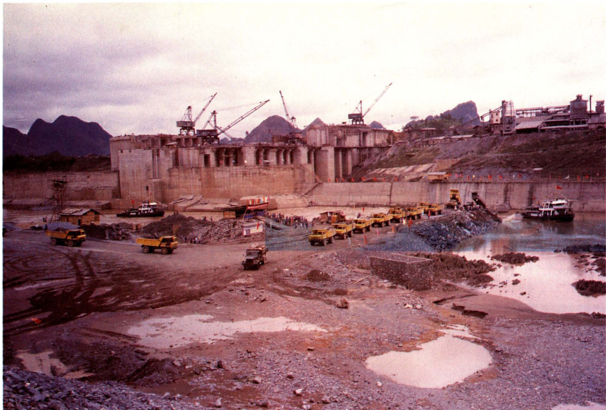
大化水电站截流施工 孙以宏摄
