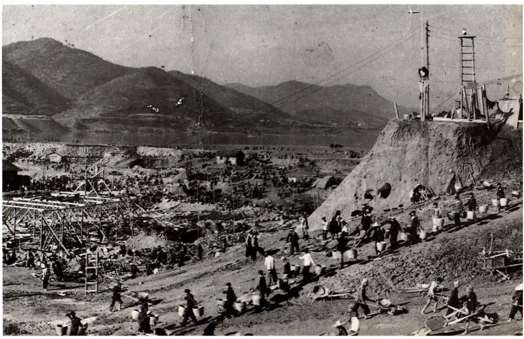
西津水电站一期木笼围堰工程在紧张施工 杜竞明提供
