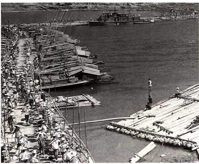
麻石水电站施工用浮排 谢庭滋提供
