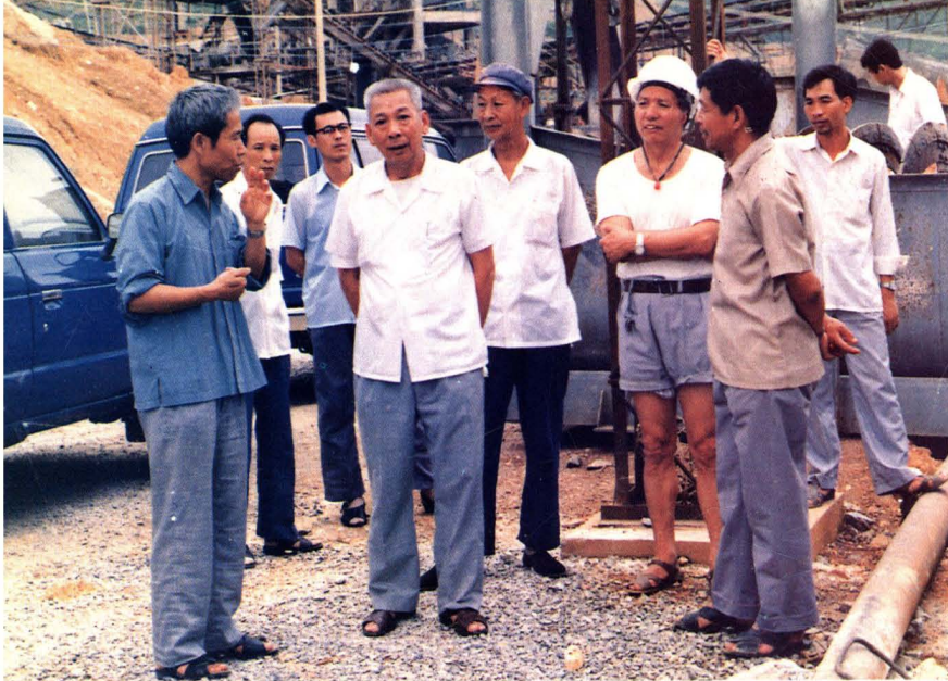
1987年6月，自治区人大常委会主任甘苦(前排左二)在岩滩水电站工地听取广西水电工程局局长柳朗静(左一)汇报
