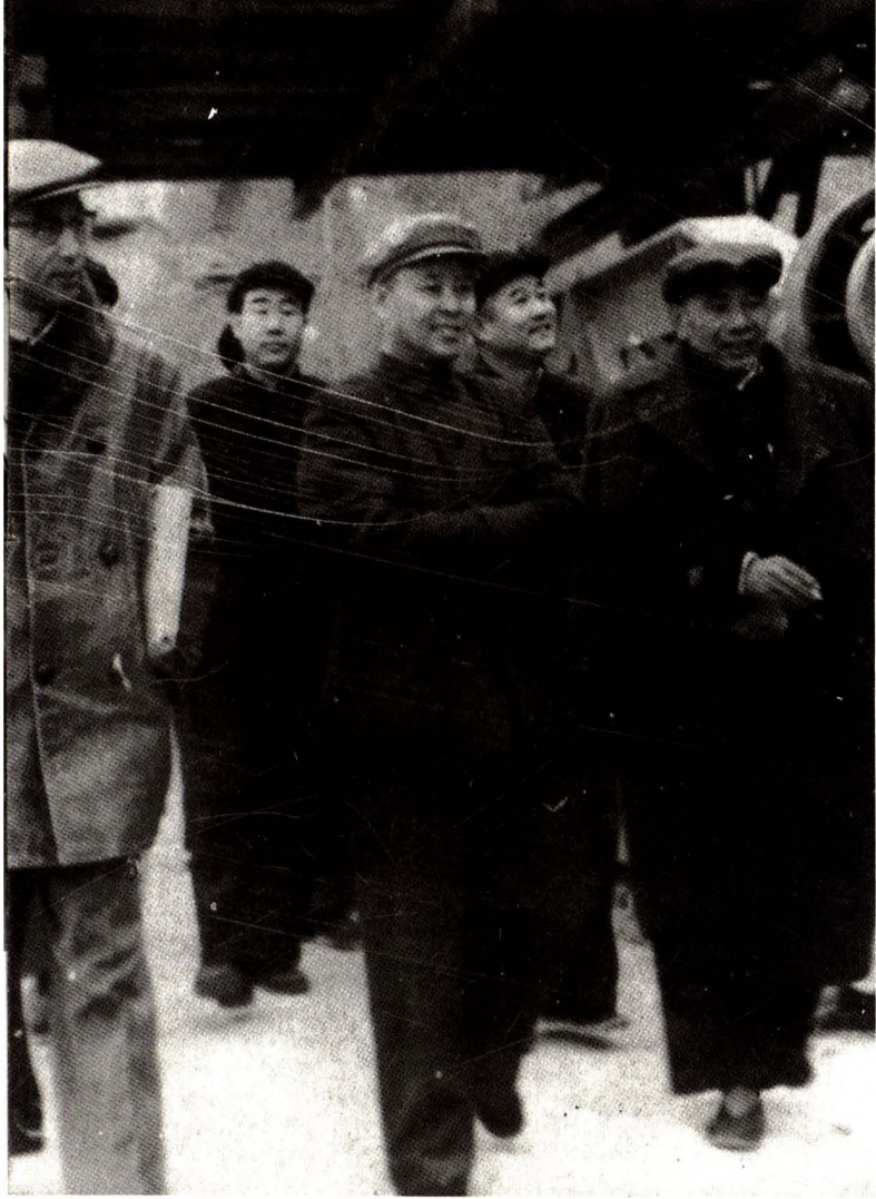
1963年元旦，自治区党委第一书记韦国清(前排右二)、书记覃应机(前排右一)在西津水电站工地检查工作
