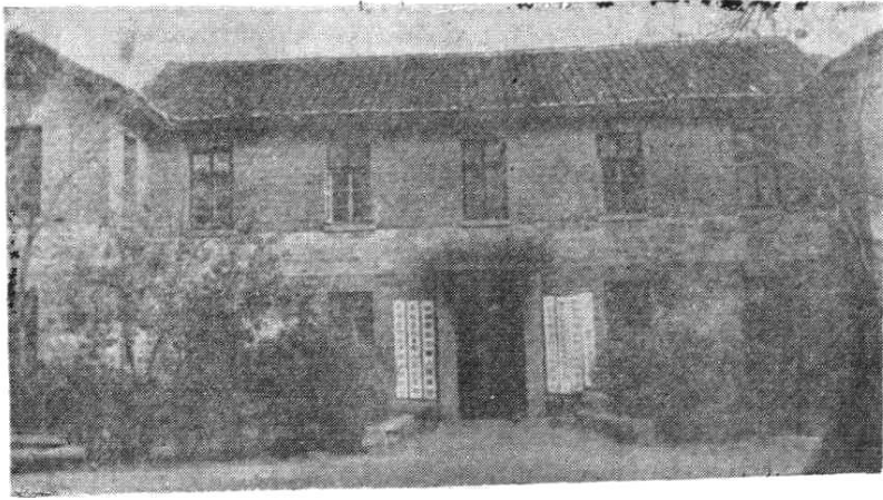
白土乡党委、乡政府办公楼
