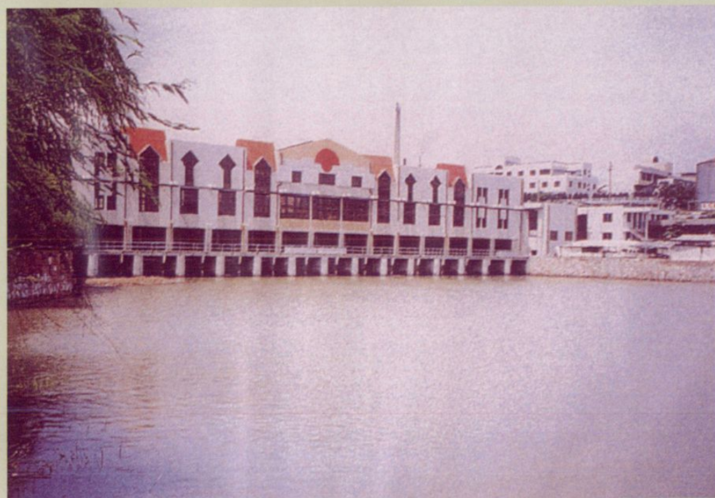
财政支持水闸工程建设
