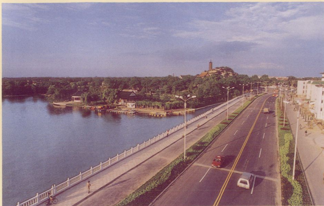
财政支持城市建设（长江路金山段）
