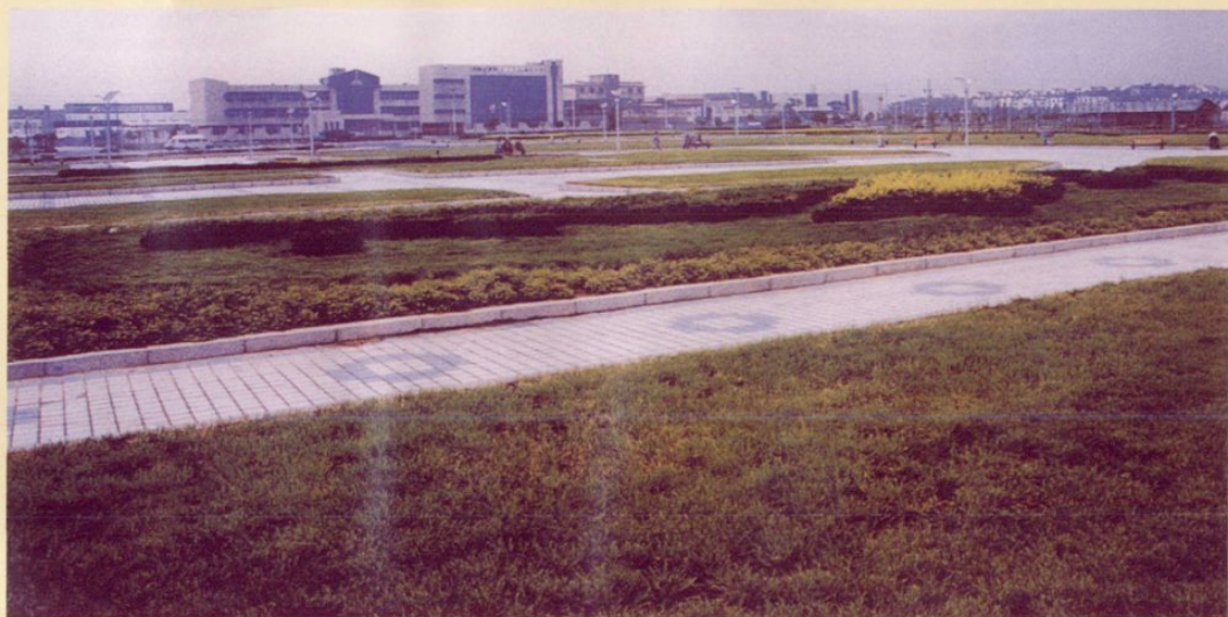
财政支持道路建设（新区广场）
