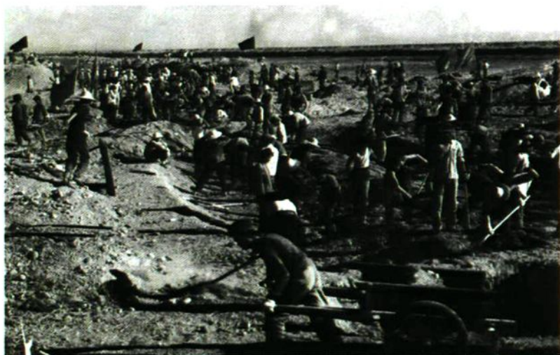
◀ 修建上游 水库(1960年)
