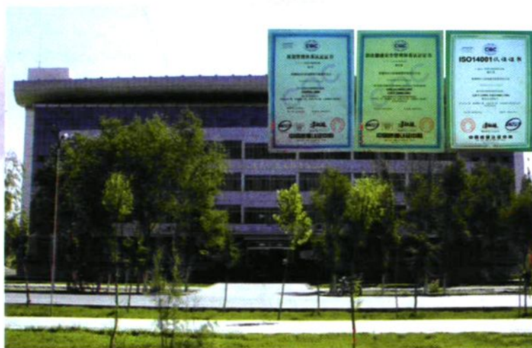
▶水利水电工 程处办公楼
