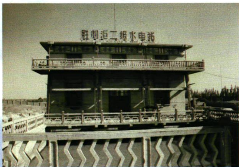
▶ 1965年承建的 胜利渠二级电站
