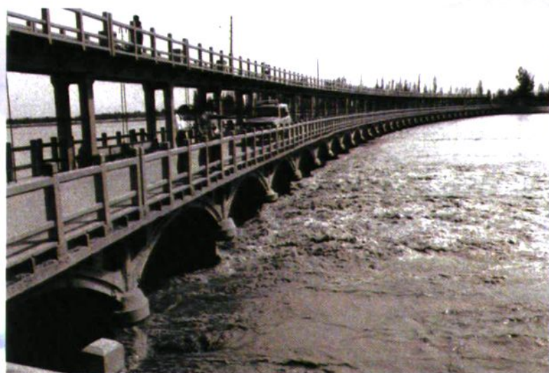
◀ 1972年建成的 塔里木河水利枢纽 工程
