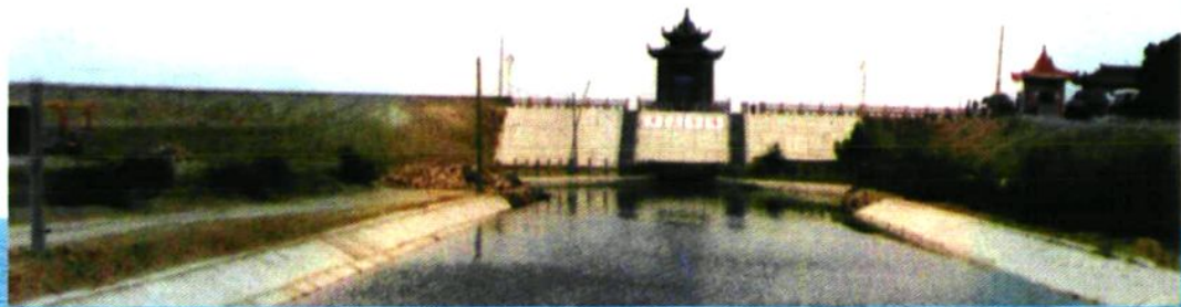
▲1994年建成的多浪水库放水闸
