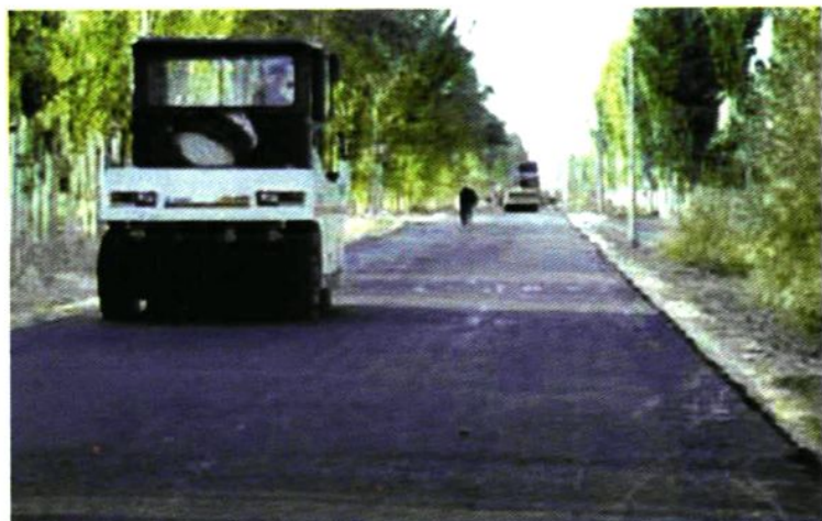
► 承建中的通 团公路(2004年)
