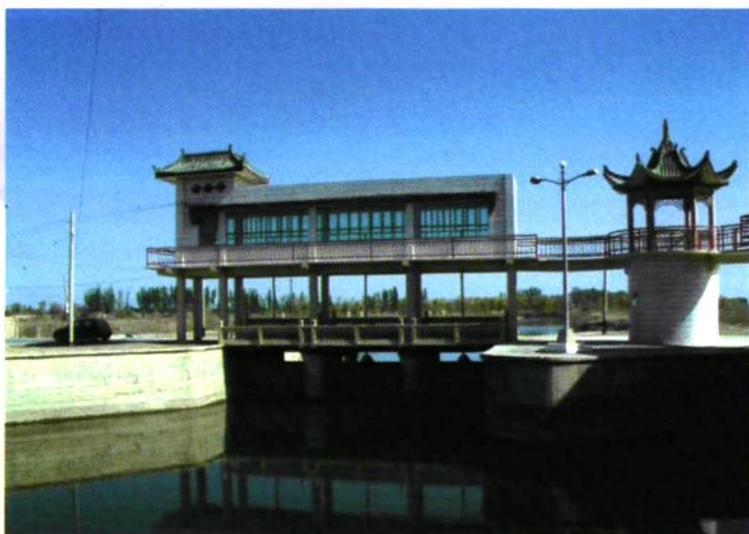
▶ 1998年建成的 塔南总干渠退水渠
