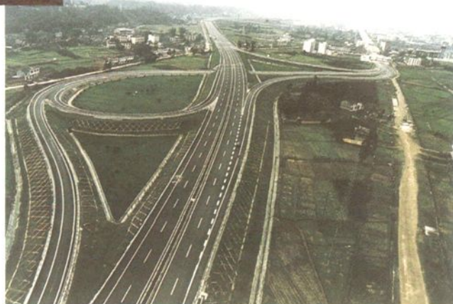
▼ 成雅高速公路 蒲江县城立交桥
