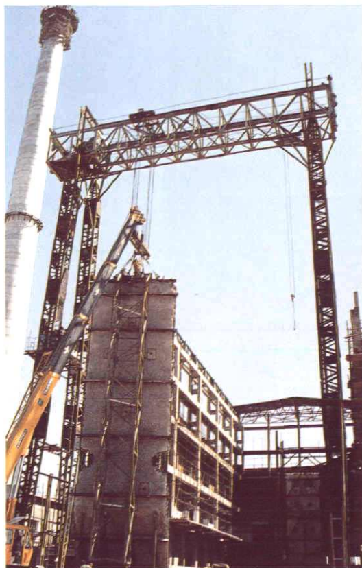
玛纳斯电厂 10 万千瓦机组水冷壁组合件吊装
