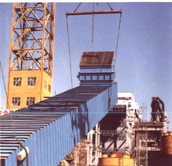
玛纳斯电厂 10 万千瓦机组冷风道吊装
