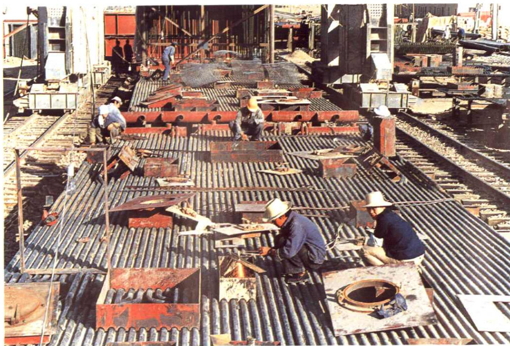
哈密二电厂 1.2 万千瓦机组 75 吨/小时锅炉组合施工现场
