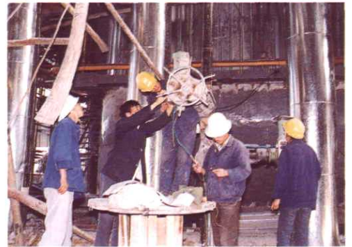
公司调试队在红雁池电厂 5 万千瓦机组进行设备调试
