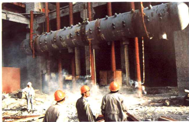
玛纳斯电厂 10 万千瓦机组 410 吨/小时锅炉 大汽包起吊就位
