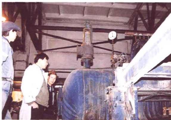
乌鲁木齐市热力站设备安装
