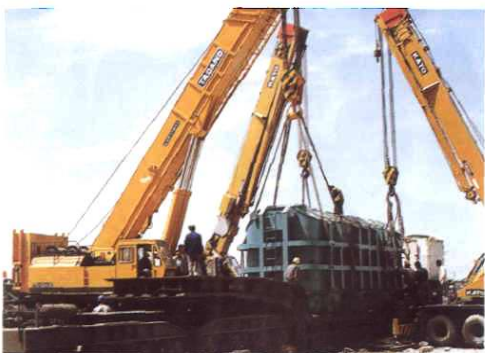
玛纳斯电厂 10 万千瓦机组 130 吨重 主变压器卸车就位
