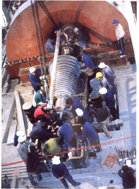
玛纳斯电厂 10 万千瓦机组汽轮机转子安装
