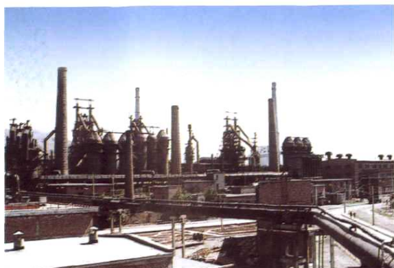
配制安装新疆八一钢铁厂 255m 3 高炉热风炉
