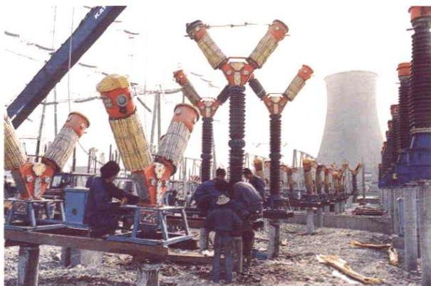
玛纳斯电厂 10 万千瓦机组 220 千伏室外变电站安装
