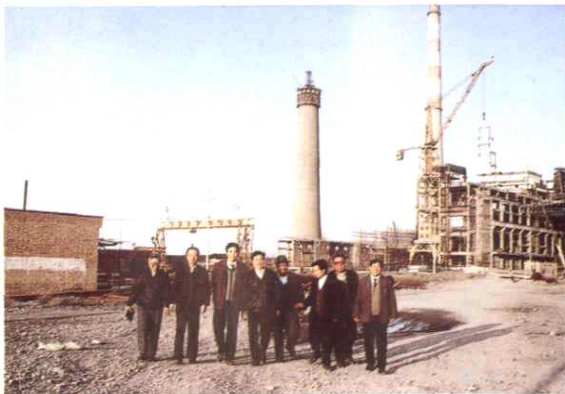
公司领导班子在玛纳斯电厂工地现场办公
