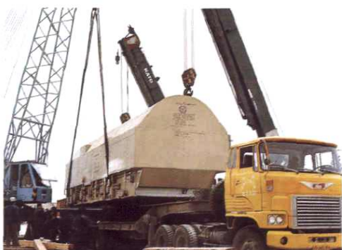
克拉玛依电厂 3.4 万千瓦燃汽轮发电 机组设备大件运输
