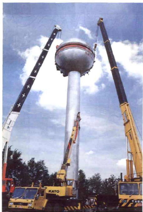
全钢结构球型水塔吊装
