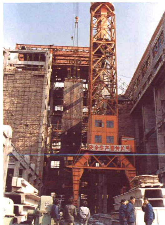
石河子热电站 0.6 万千瓦机组安装施工现场
