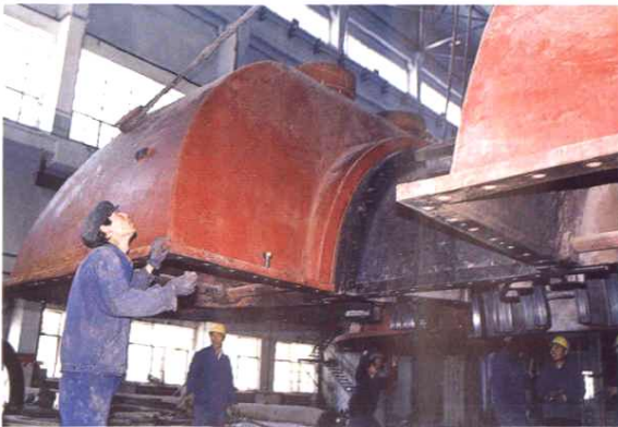
玛纳斯电厂 10 万千瓦机组上汽缸吊装就位
