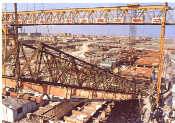
玛纳斯电厂 10 万千瓦机组施工现场
