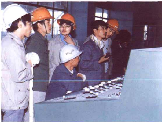
公司调试队在玛纳斯电厂 10 万千瓦机组进行启动调整试验
