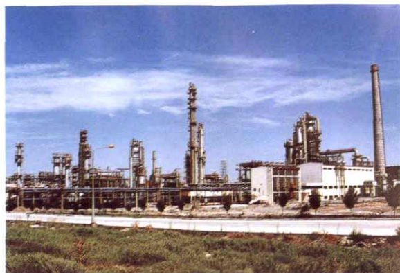
安装乌鲁木齐石化厂 120 万吨催化裂化常减压装置及配套设备
