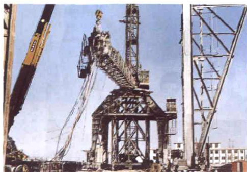
自制 75 吨塔式吊车组装
