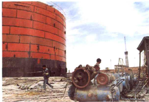
配制安装新疆最大的 1000m 3 油罐
