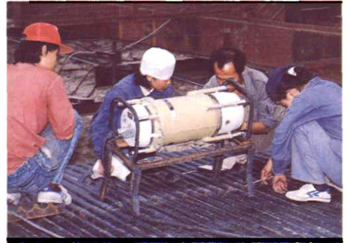
公司调试队在施工现场进行无损探伤
