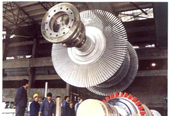
玛纳斯电厂 10 万千瓦机组汽轮机转子起吊
