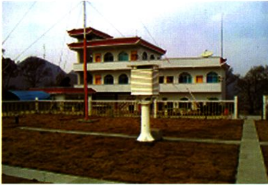
观测场及办公楼
