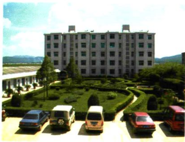
昆阳分局职工住宅楼
