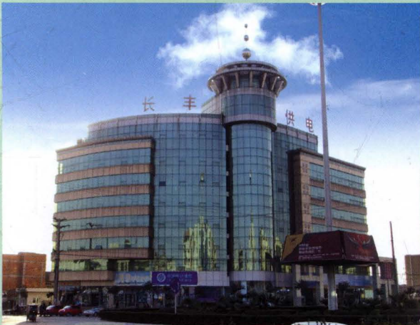
长丰供电公司调度大楼
