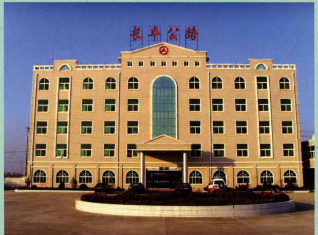
长丰公路分局办公大楼
