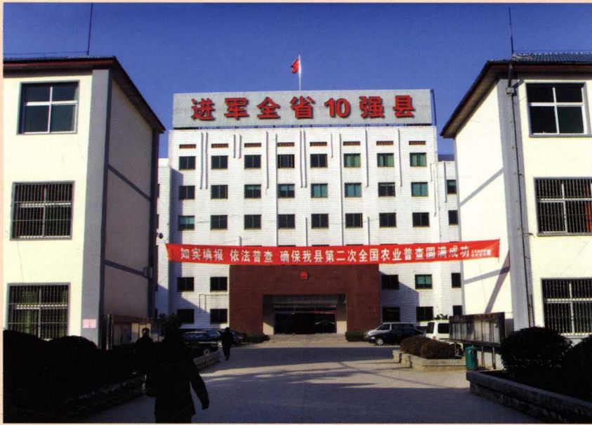
中共长丰县委、县政府办公大楼
