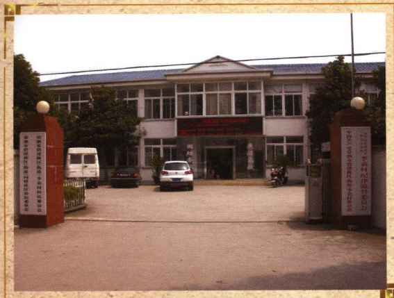
中共李袁村委员会、 李袁村村民委员会办公楼
