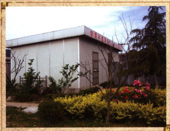
李袁村集居区生活污水处理站
