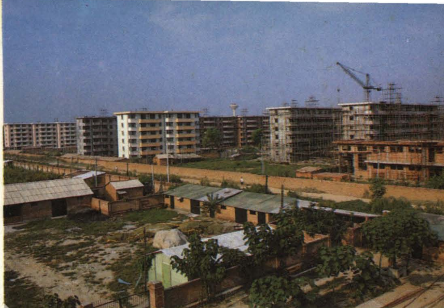
西安市西南郊建设中的 电子城
