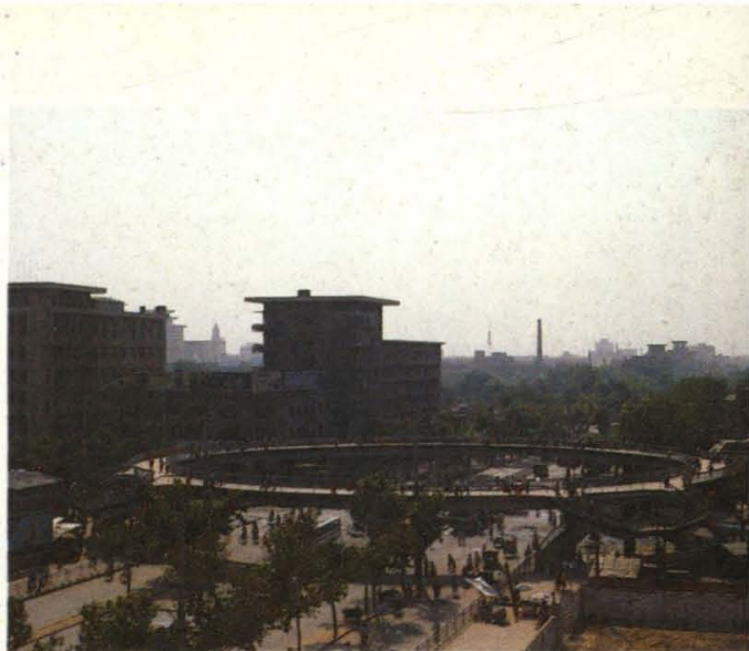
西安市第一座环形人行天桥 ——东五路环形人行天桥
