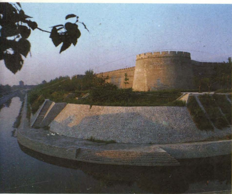
建设中的西安环城立体公园 (四个城角中唯一的半圆形城角)
