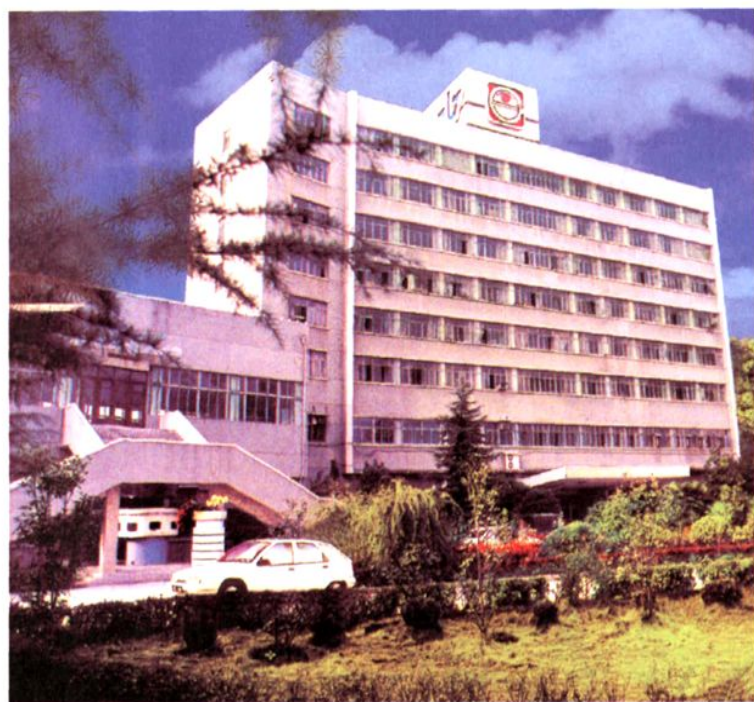
● 车身厂办公大楼
