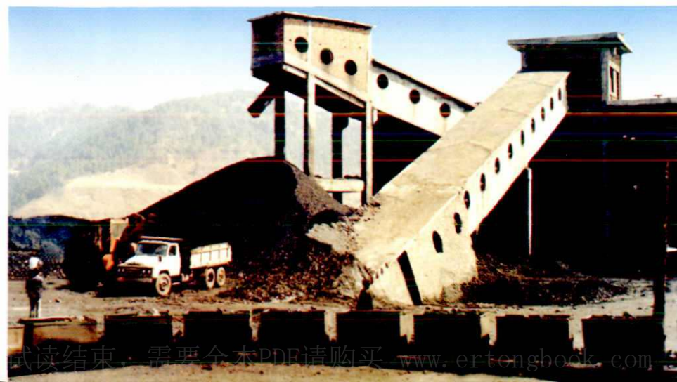
延安车村煤矿
