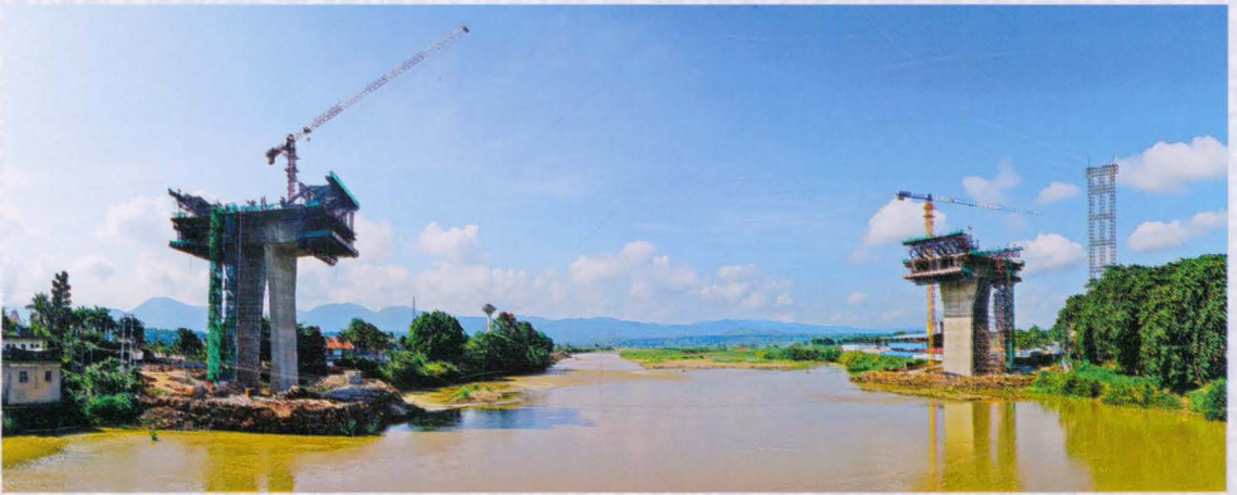
龙瑞高速公路瑞丽江大桥施工现场（钱景泰摄于2014年6月）
