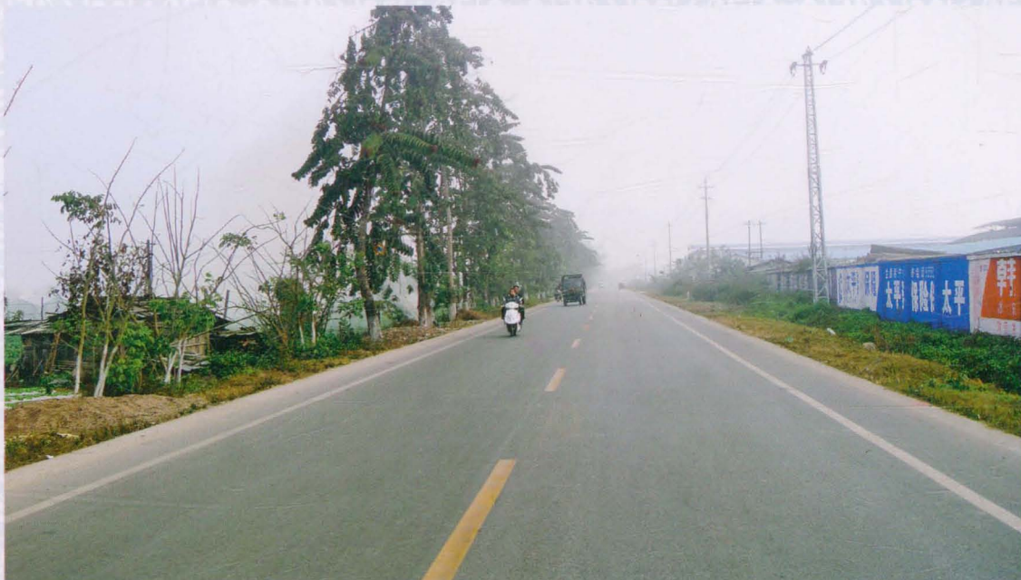
2010年12月28日，瑞丽至弄岛公路改建工程建成通车，图为滇弄段。（杨进才摄于2011年1月）
