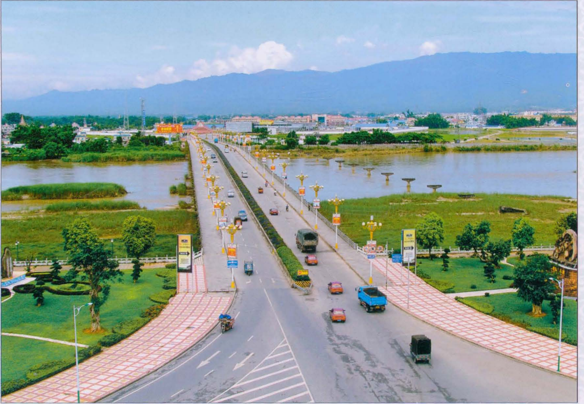
2005年9月12日，姐告大桥复线桥建成通车。（赵重天 摄）
