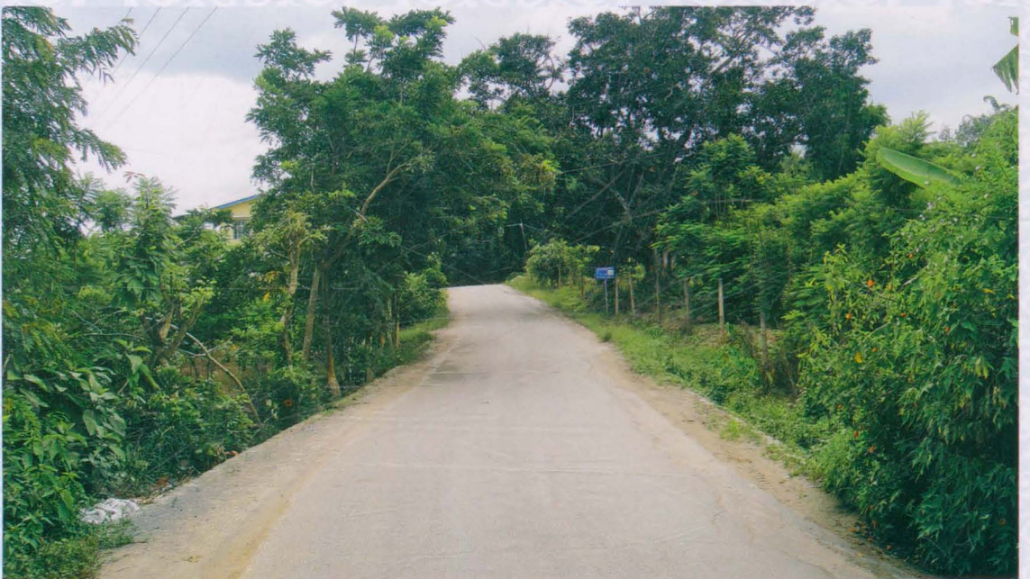
2007年12月24日，瑞丽城子至姐相公路改造工程完工投入使用。（杨进才 摄于2014年8月）
