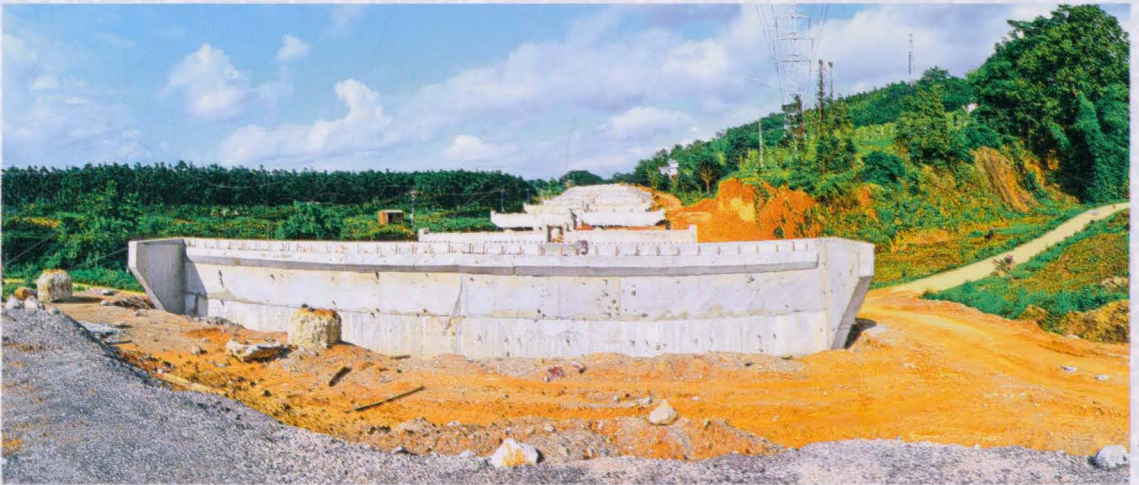
龙瑞高速公路伙马段施工现场（钱景泰摄于2014年6月）
