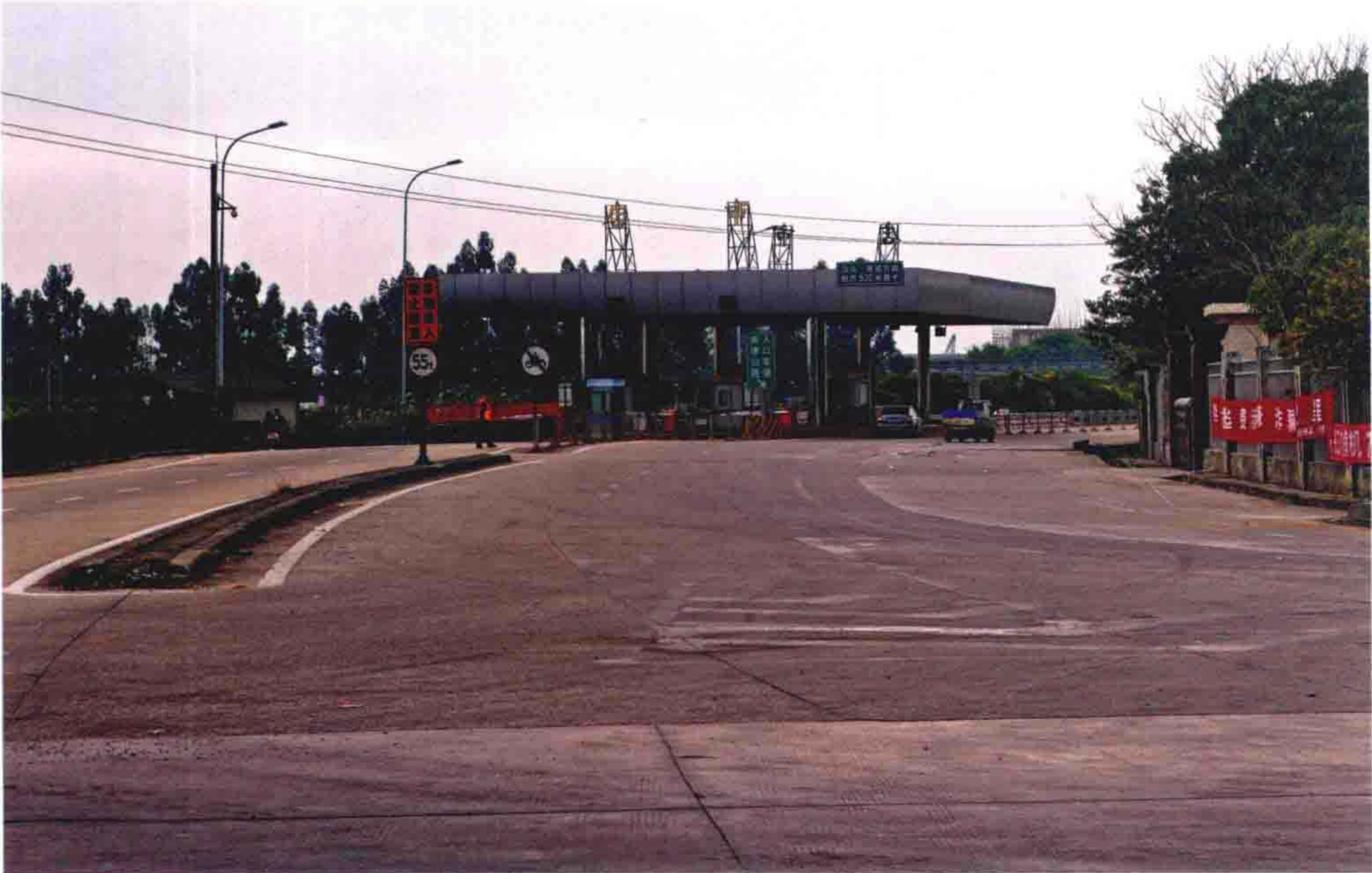
汕汾高速公路店市入口
