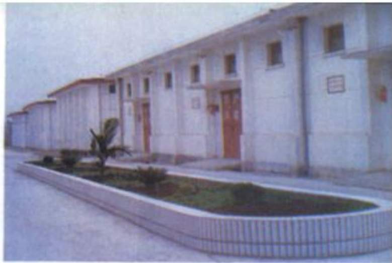
國家糧食儲備庫和縣直屬糧庫庫區一角
