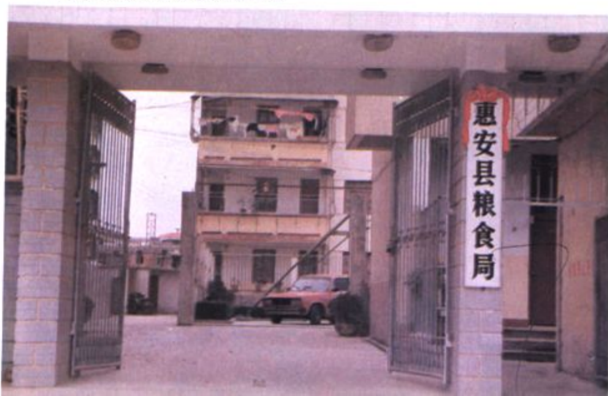
1989年落成的惠安縣糧食局綜合樓
