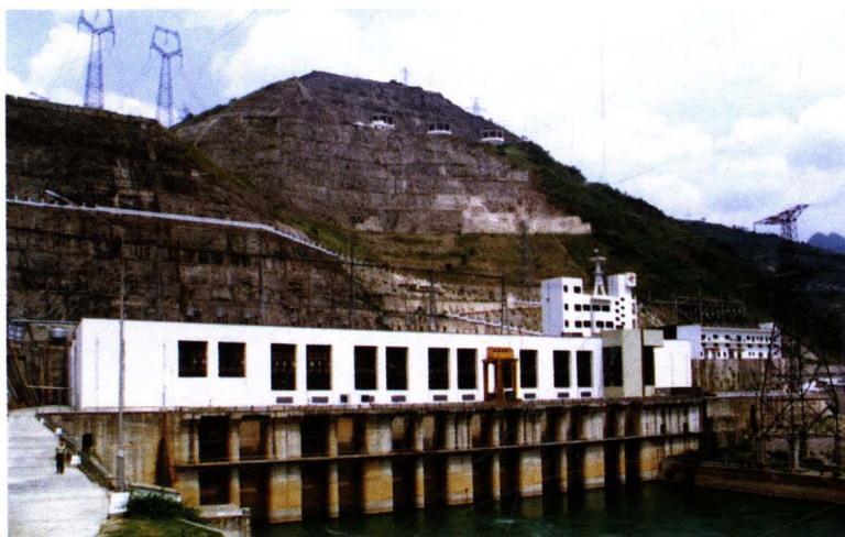
天生桥二级水电站
