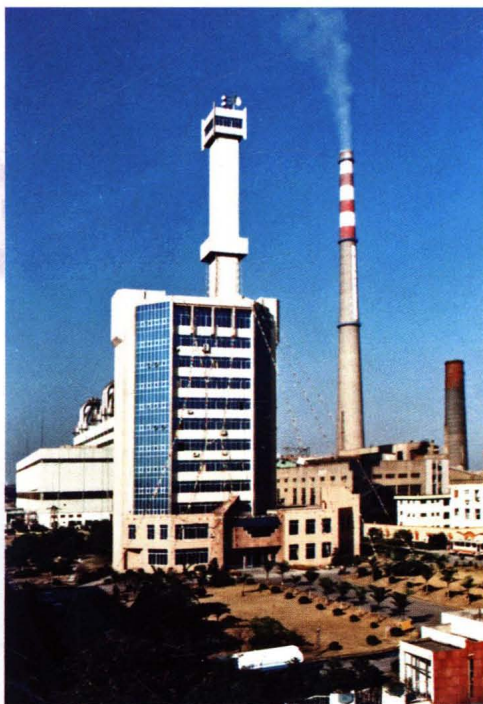
1992年12月，柳州火电厂（总装机容量40万千瓦）扩建工程开工建设，1995年11月，两台机组投产发电
