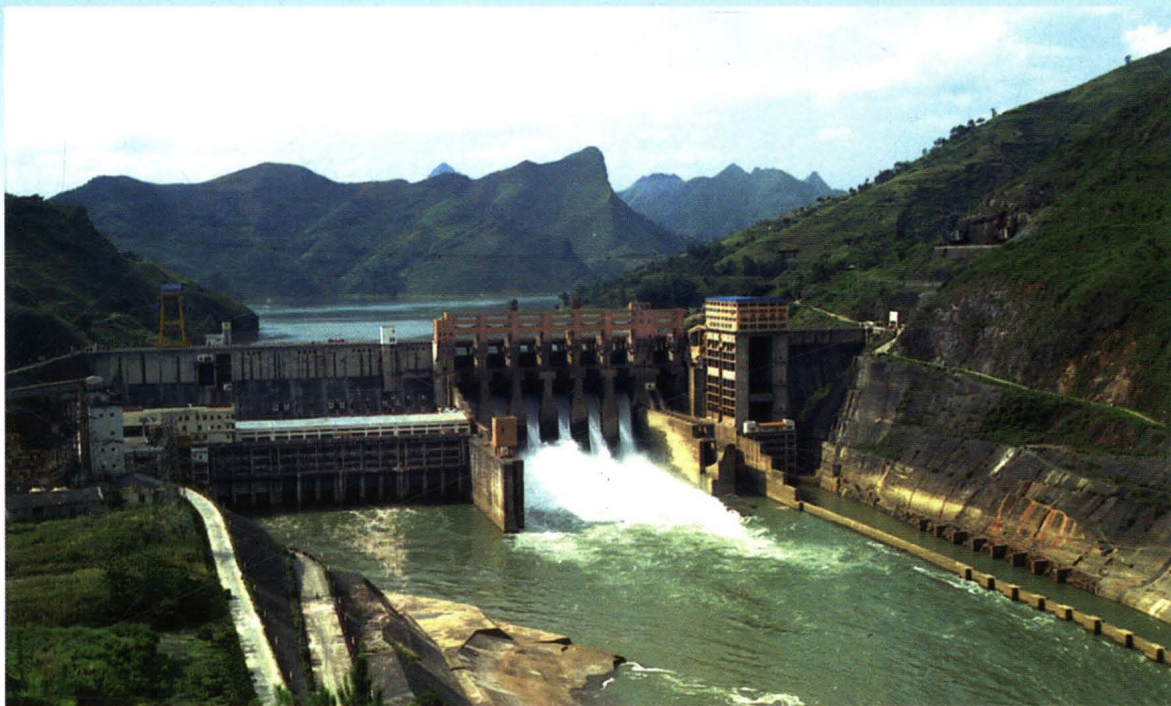
广西岩滩水电站
