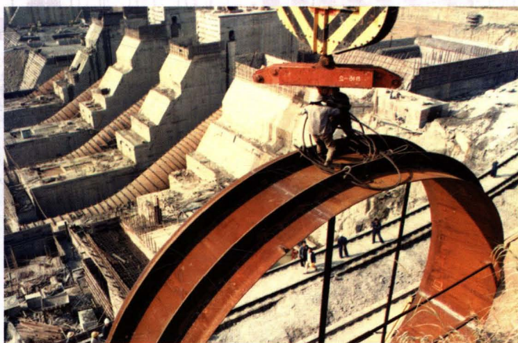
岩滩水电站建设中，施工人员正在吊装引水压力钢管
