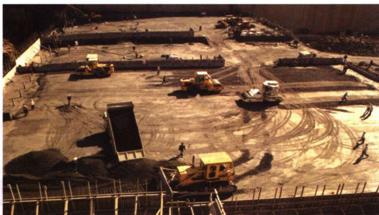
岩滩水电站在大坝围堰建设中采用碾压混凝土施工新技术
