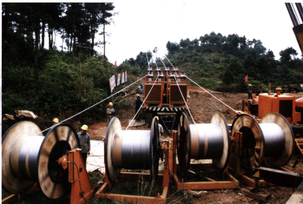
1991 年开始，张力放线设备、技术在广西送变电建设公司的输电线路工程施工中广泛使用
