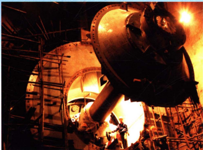
1995年11月，建设中的百龙滩水电站进行贯流式机组安装
