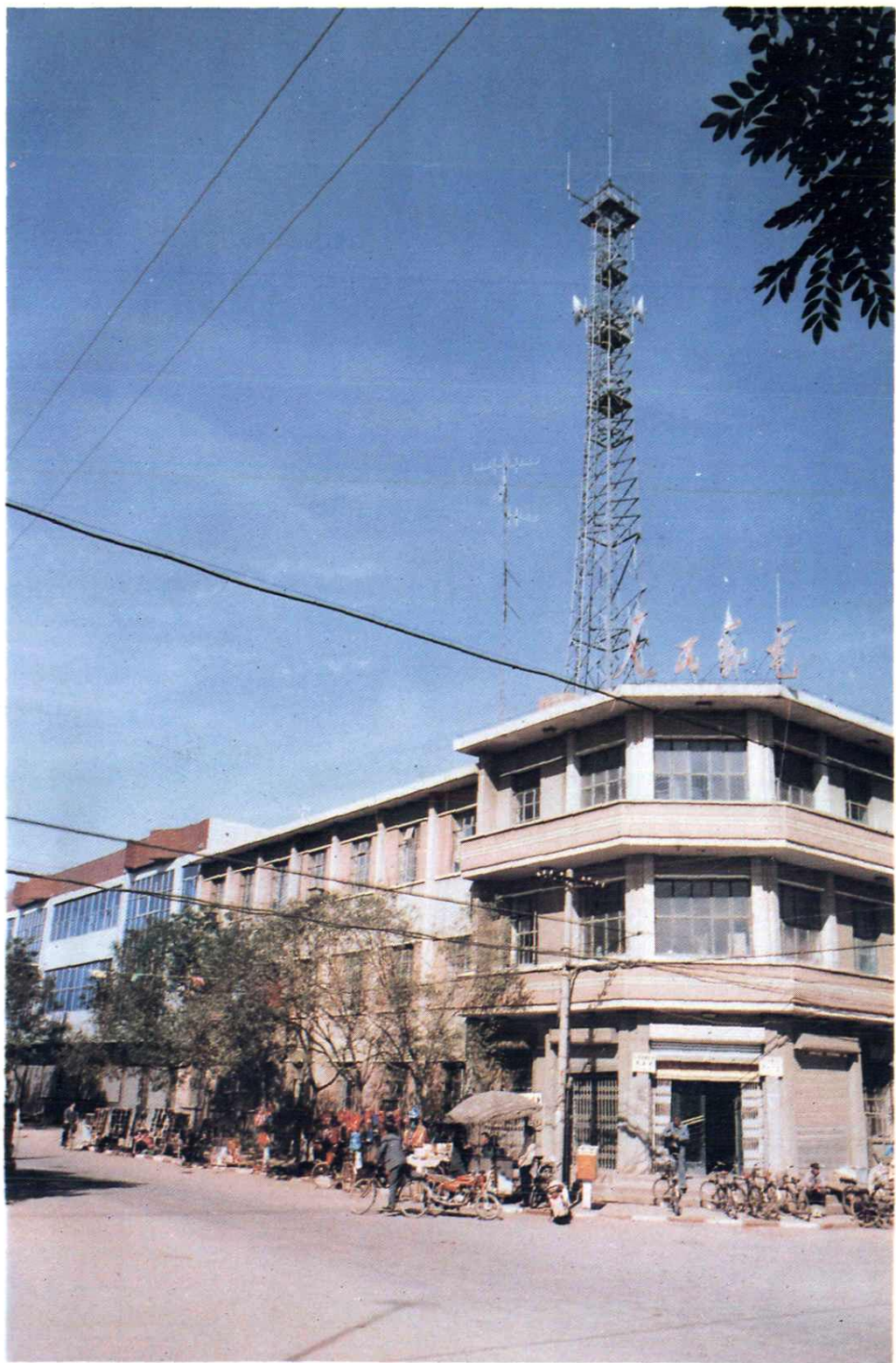
县局综合通信楼全景
